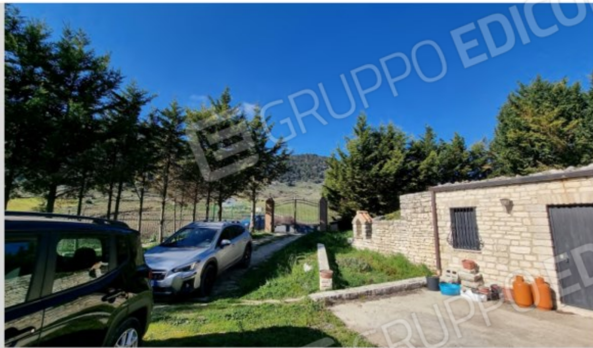
FOTO N.3 Ingresso all'appartamento in villa. (Lotto 1)
