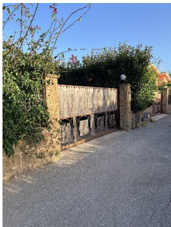
Foto 4- Accesso alla villetta bifamiliare
