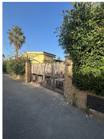
Foto 3- Accesso alla villetta bifamiliare
