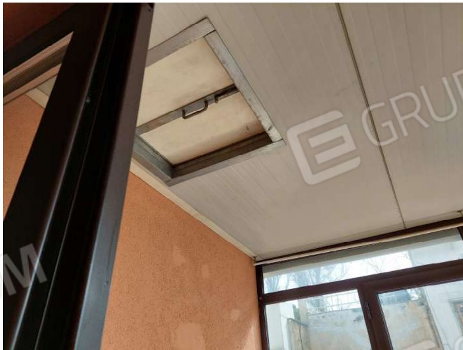
Foto 18 – Terrazzino verandato piano 2°
