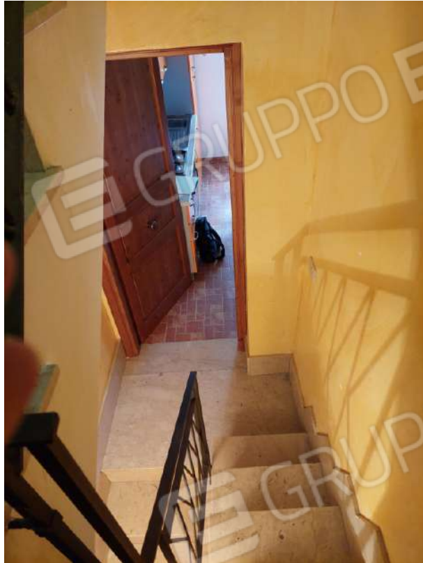
Foto 7 – Pianerottolo di piano primo
