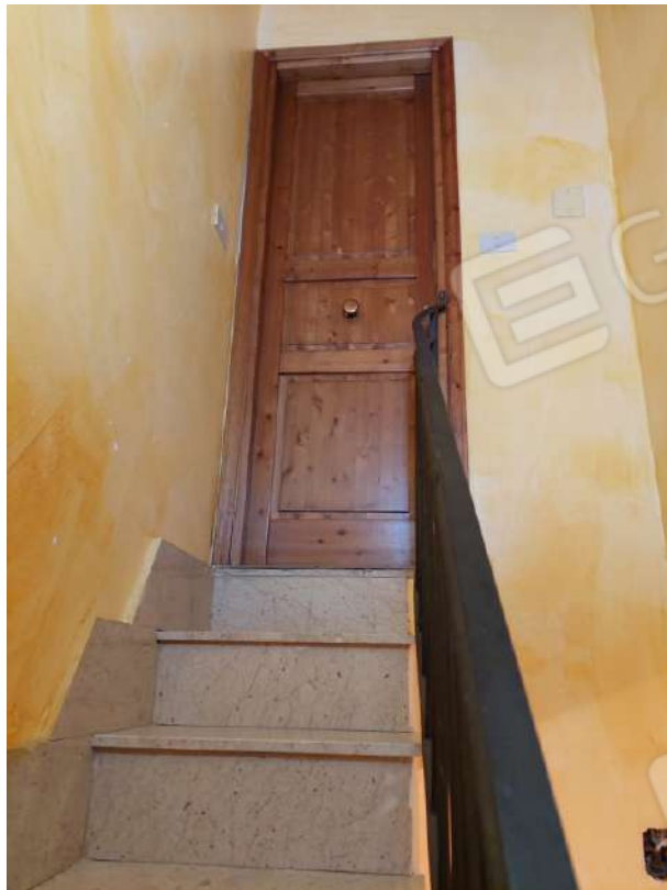
Foto 8 – Rampa di piano secondo
