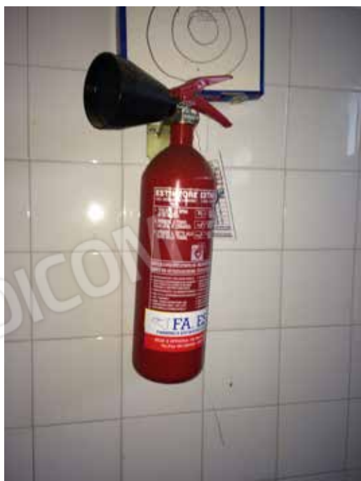
67. N. 2 estintori di cui uno da 2 kg e uno da 6 kg (Zona confezionamento - Edificio A).
