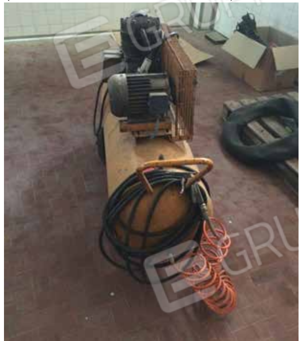
53. Compressore da 200 l n. 256627 (Zona confezionamento - Edificio A).
