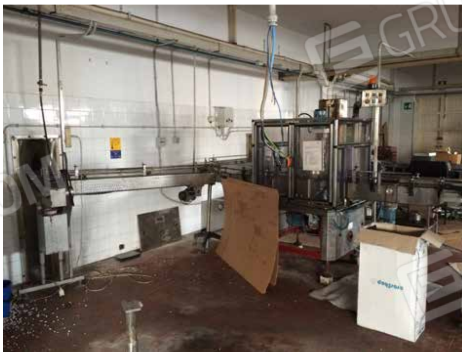
47. N. 3 prolungamenti di rulli trasportatori di cui al n. 20 dell'inventario (Zona confezionamento - Edificio A).
