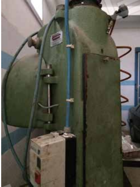
209. Macchinario REV MEC collegato al compressore (Edificio B - P. Terra)
