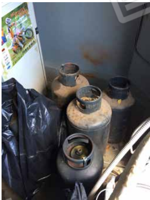
273. N. 6 bombole vuote (Edificio A - P. Terra dep. scarti di lavorazione)
