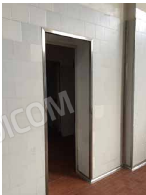
23. Zona servizi igienici
