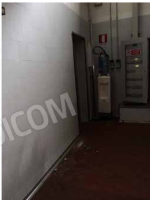
27. Zona servizi igienici
