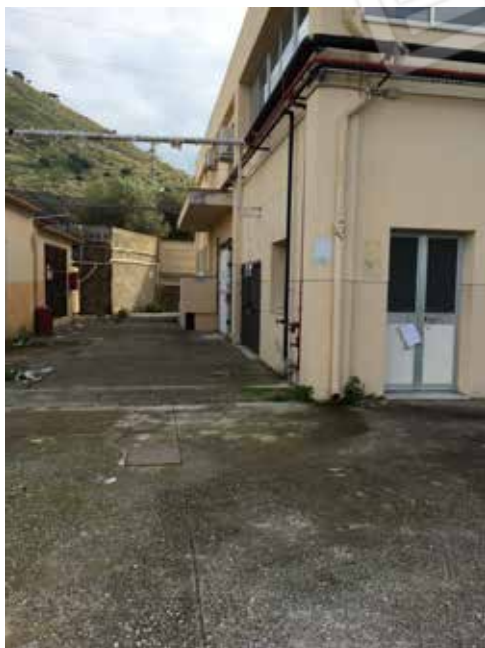
5. Ingresso al laboratorio e vista dei locali tecnici
