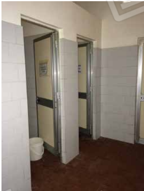
25. Zona servizi igienici
