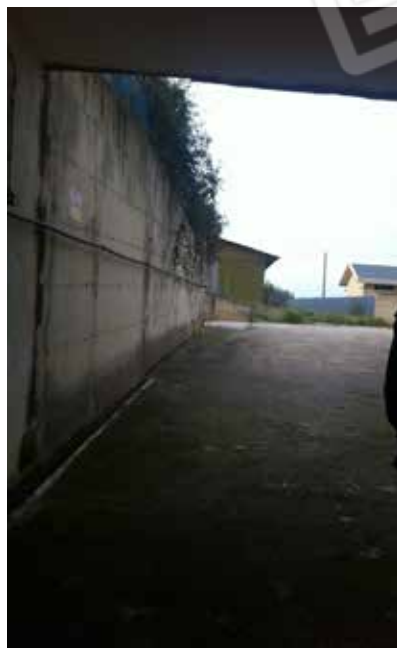
65. Accesso al piano seminterrato
