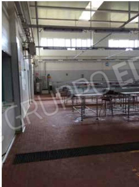
10. Zona lavorazione (piano terra)
