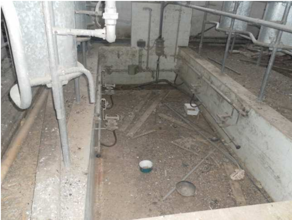
Vasca interna alla sala mungitura
