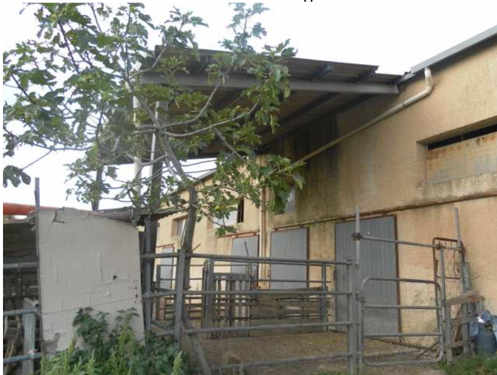
Prospetto Ovest Capannone (Tettoia) Particella 170 sub 6
