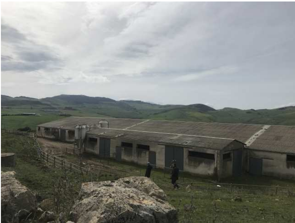
Prospetto Est Capannone particella 170 sub 6
