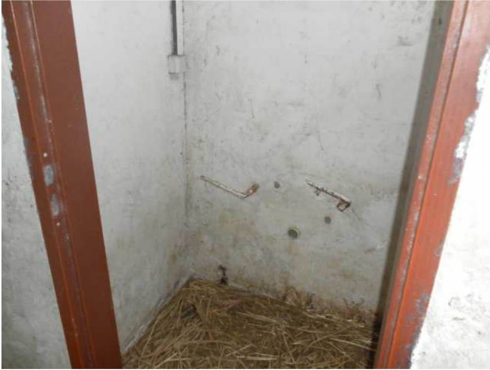
Interno Capannone- W.C.
