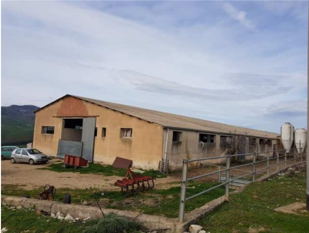
Prospetto Sud-Est Capannone particella 170 sub 6
