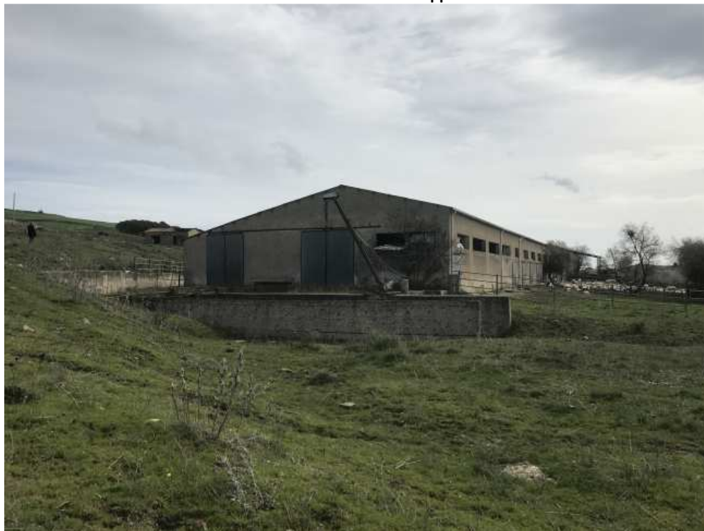
Prospetto Nord- Ovest Capannone particella 170 sub 6
