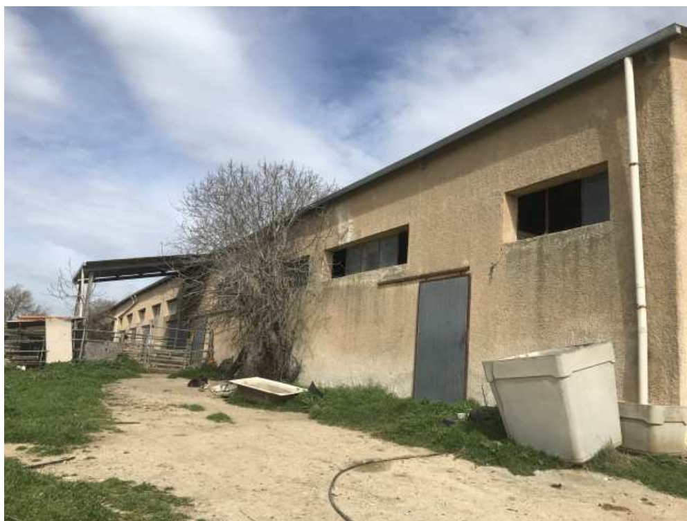
Prospetto Ovest Capannone Particella 170 sub 6
