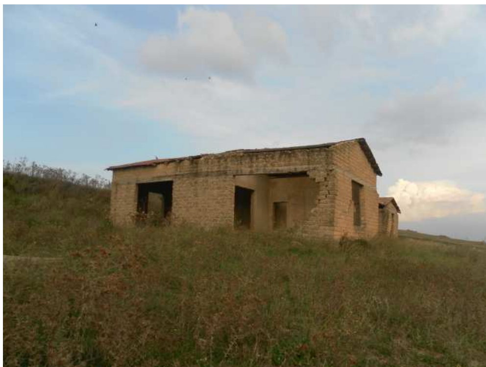
Prospetto Sud-Ovest casa di abitazione part. 170 sub 4
