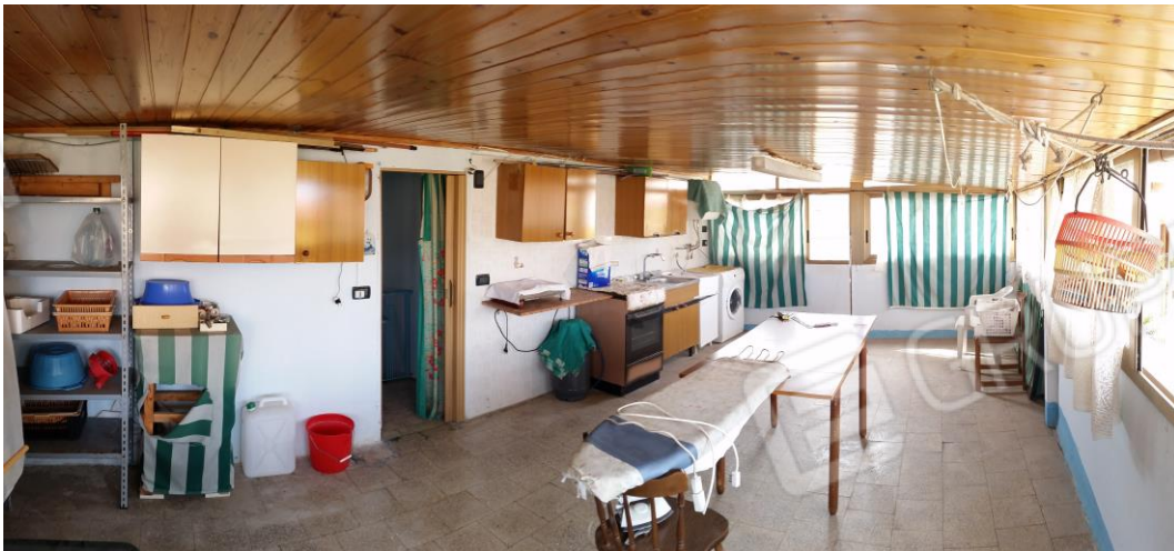
Figura 42: Vista del terrazzo coperto con struttura metallica e onduline in fibro-cemento e controsoffitto in legno
