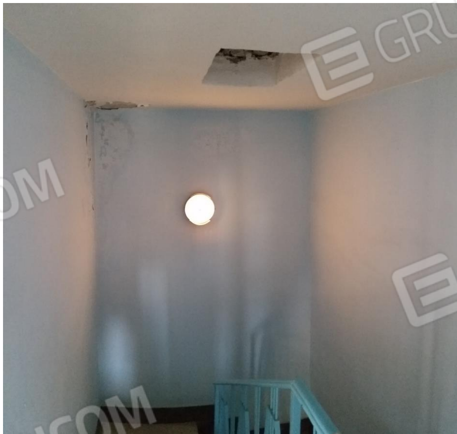
Figura 38: Vista del vano scala in corrispondenza del terzo piano
