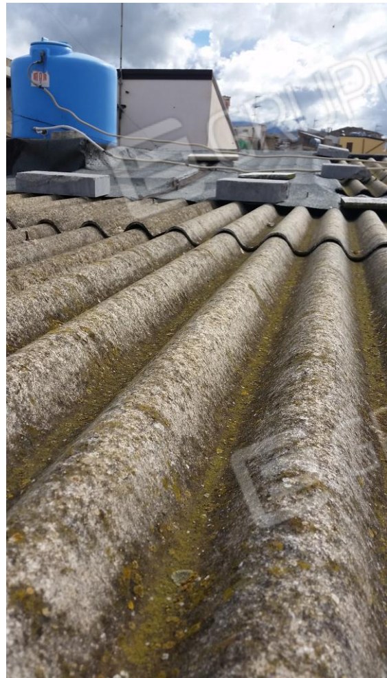
Figura 45-46: Particolari della copertura in onduline in fibro-cemento
