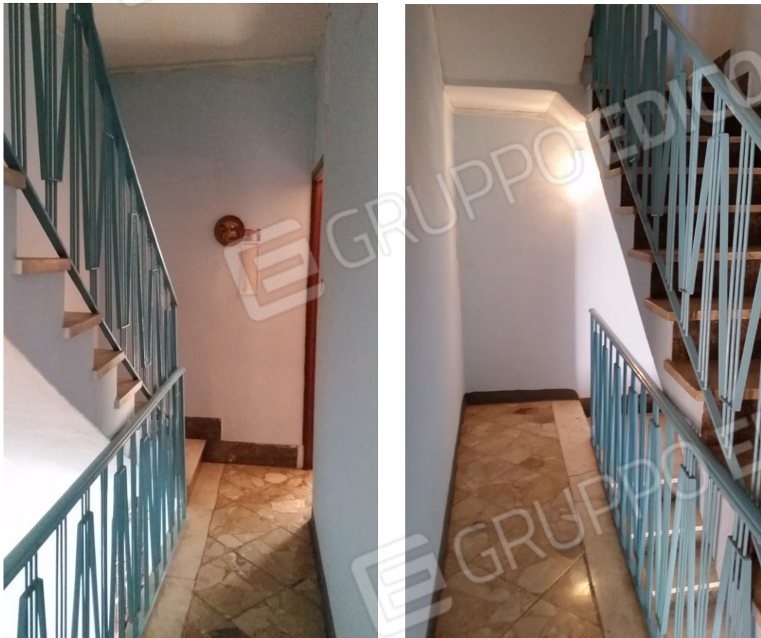
Figura 8-9: Vista della scala e del ballatoio di sbarco al primo piano
