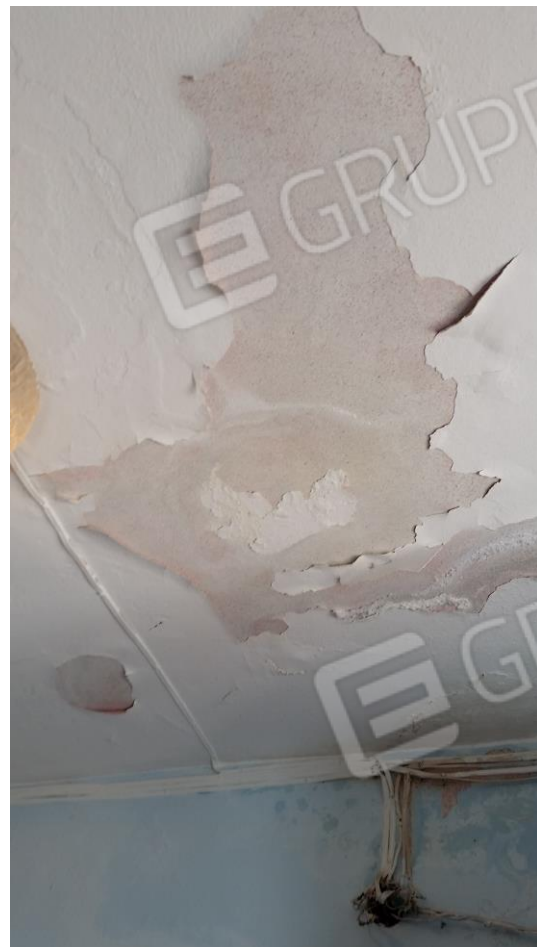
Figura 6-7: Ammaloramenti presenti in corrispondenza dell'intradosso del solaio nel vano d'ingresso dell'immobile de quo
