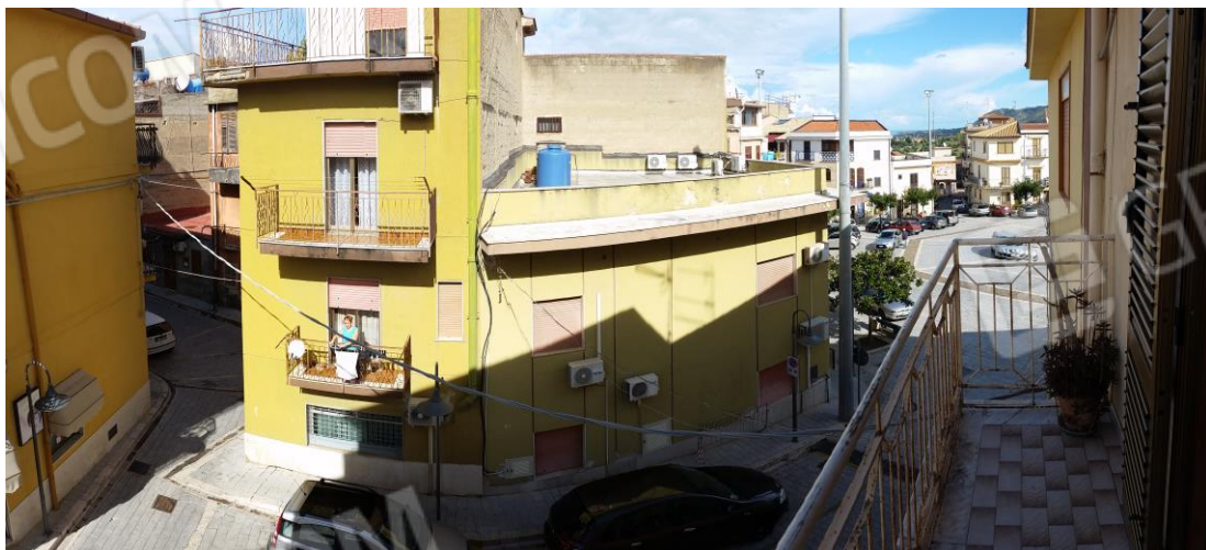
Figura 30: Vista del balcone di piano secondo su prospetto laterale
