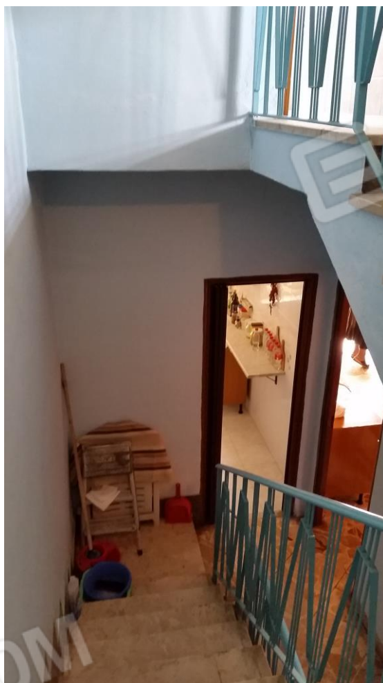
Figura 36: Vista del vano scala tra il secondo ed il terzo piano
