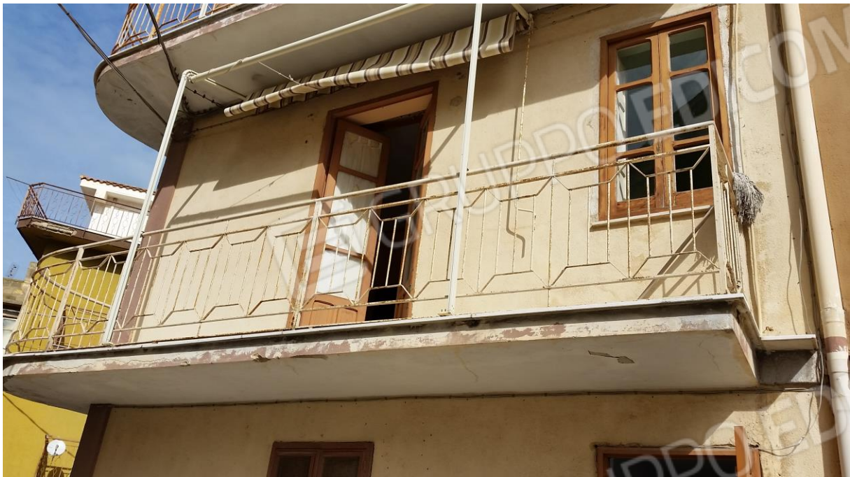
Figura 18: Vista del balcone di primo piano – prospetto principale
