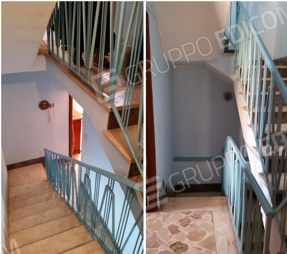
Figura 22-23: Vista del vano scala e del pianerottolo di sbarco al secondo piano
