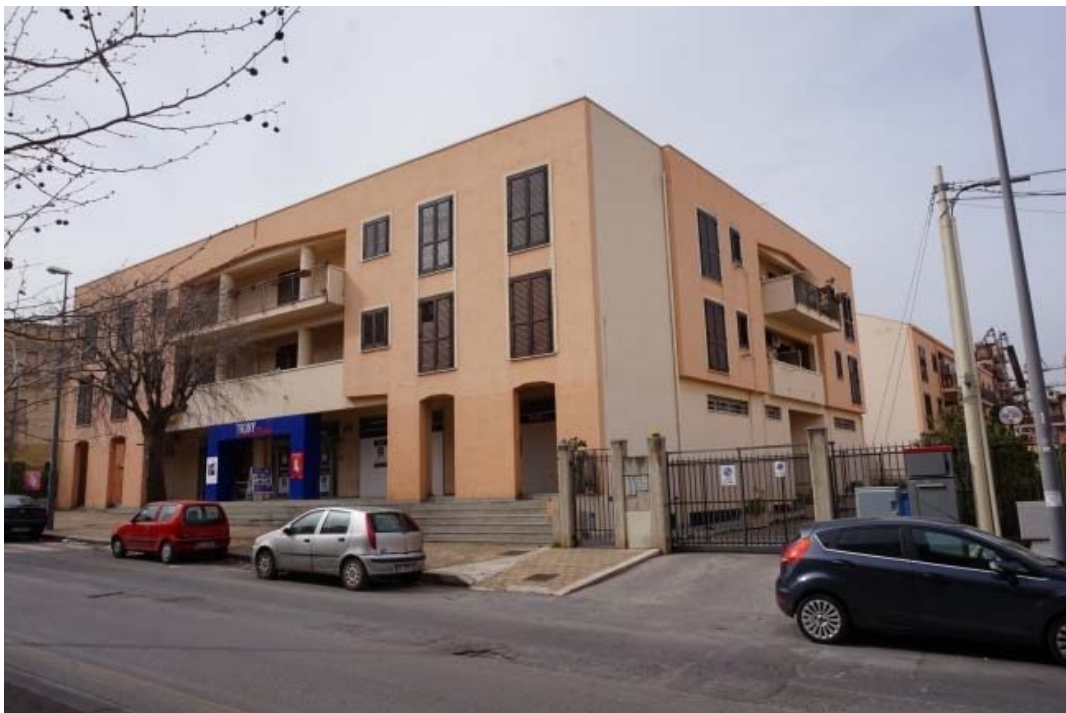
prospetto su via Baldassare Scaduto
