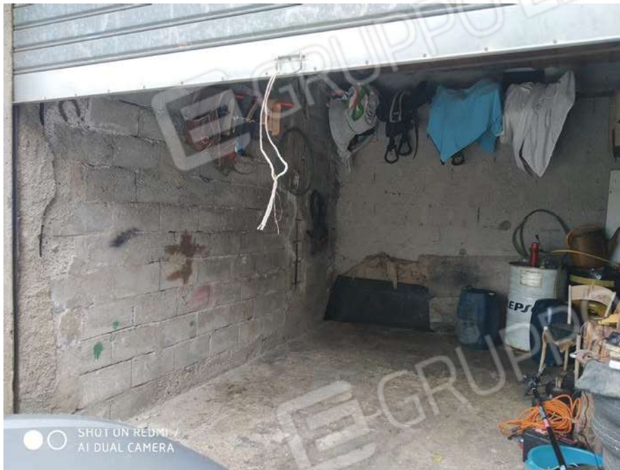
FIGURA 18 – FOTO INTERNO – GARAGE – BENE 3
