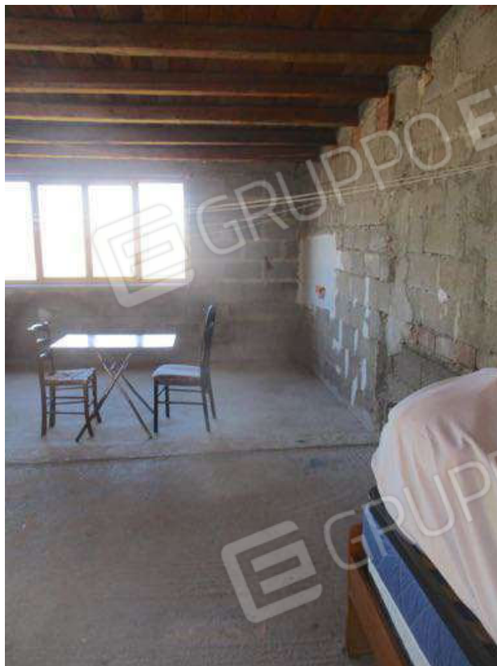
Foto 27- vista del piano 3° sottotetto ex terrazza
