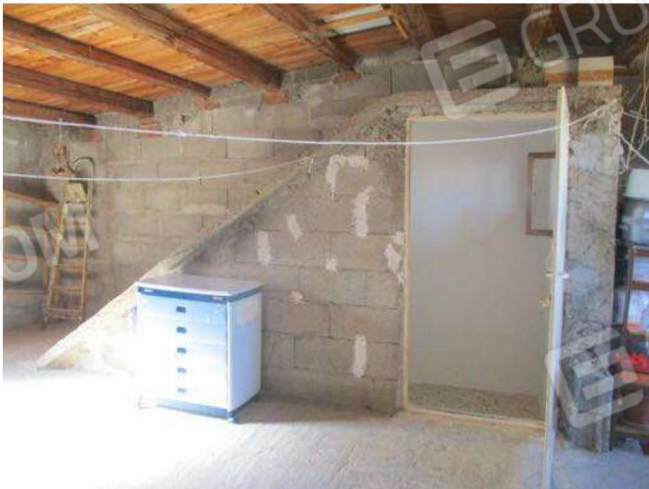
Foto 26- vista del piano 3° sottotetto ex terrazza
