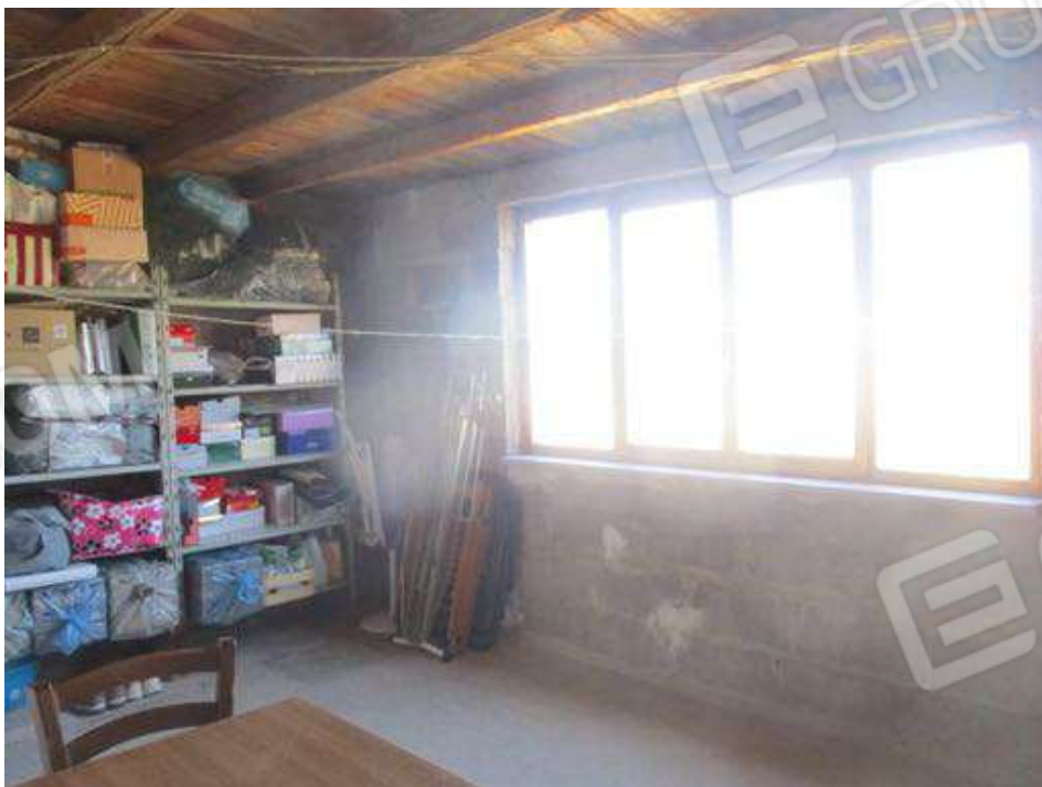
Foto 24- vista del piano 3° sottotetto ex terrazza
