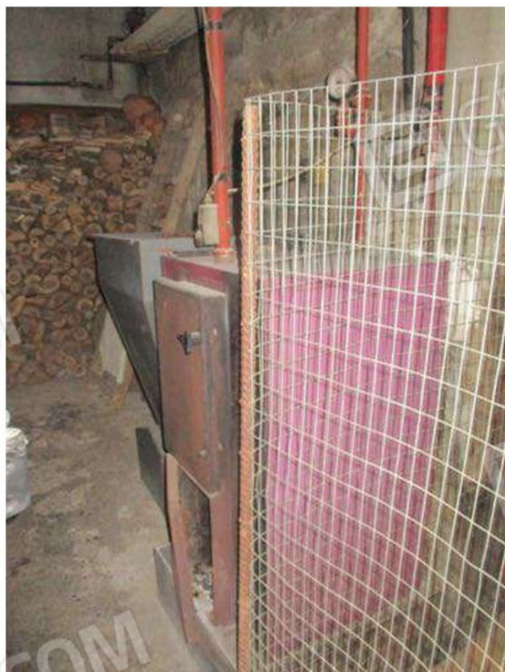
Foto 8- vista del magazzino in CF f. [redacted] via Verga (civ.11)
