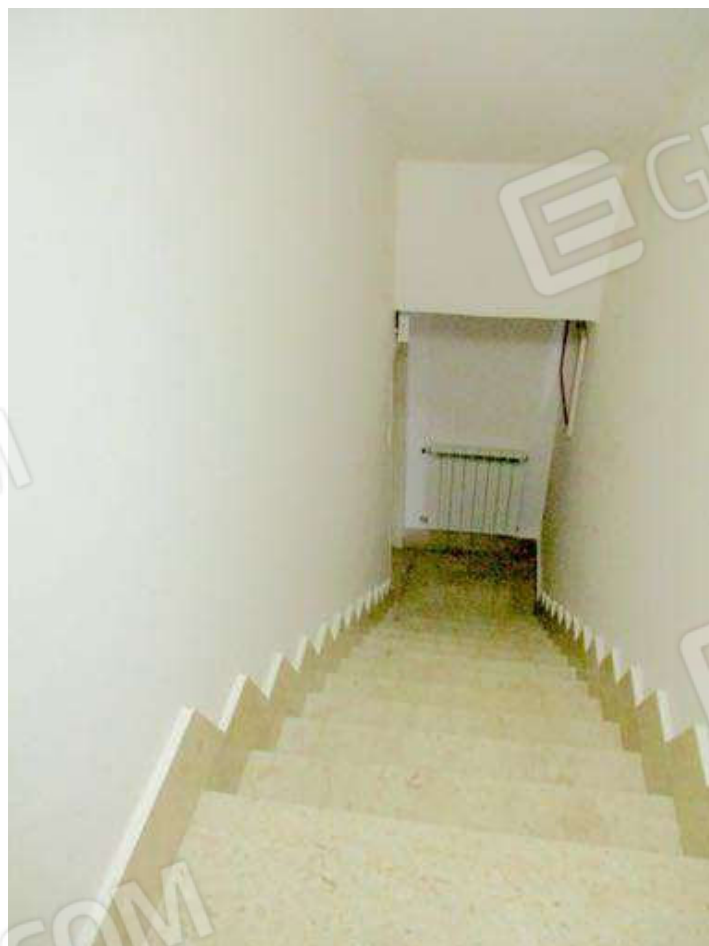
Foto 18- vista della scala di collegamento interna
