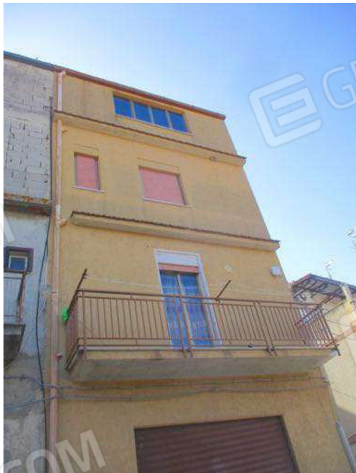
Foto 2- vista del prospetto su via Verga (civ.11)
