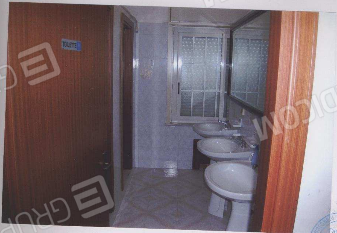
Foto n° 34 Primo piano, w.c. n. 1
