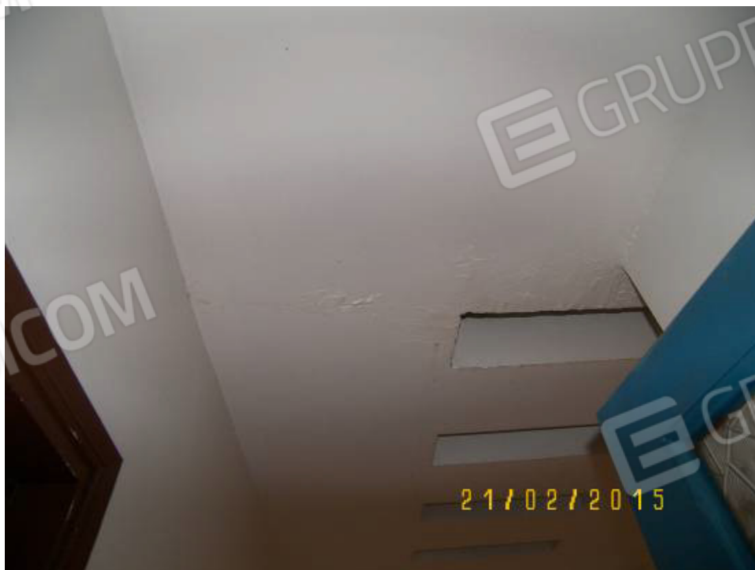
Foto n. 25 – Copertura vano scala
