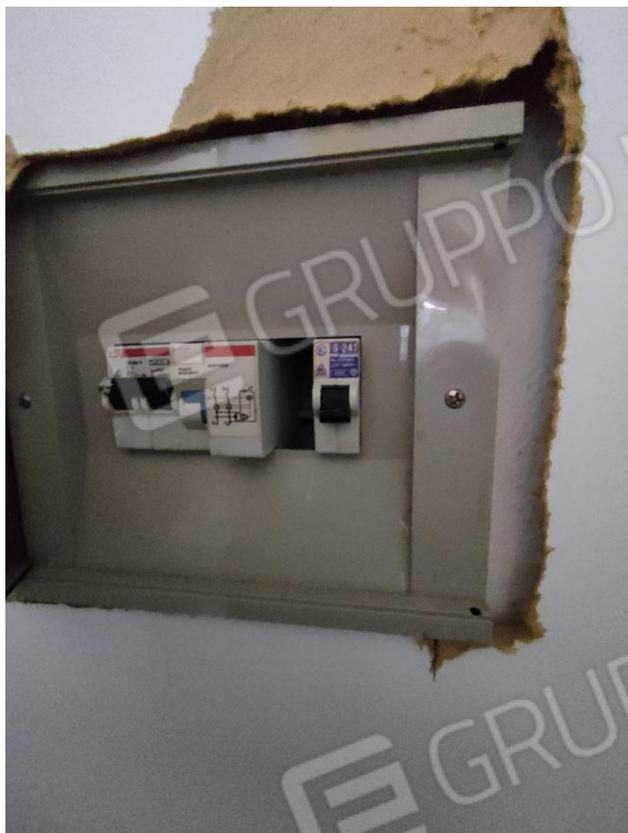
Figura 32: Particolare quadro elettrico con interruttore salvavita
