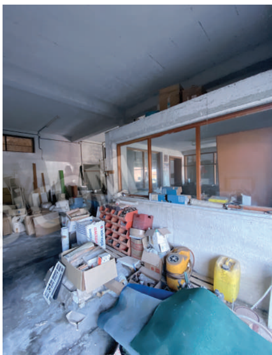
Foto 27. Piano seminterrato, Vano 3.
