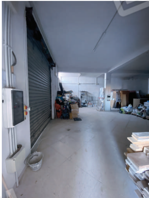
Foto 17. Piano seminterrato, Vano 1.
