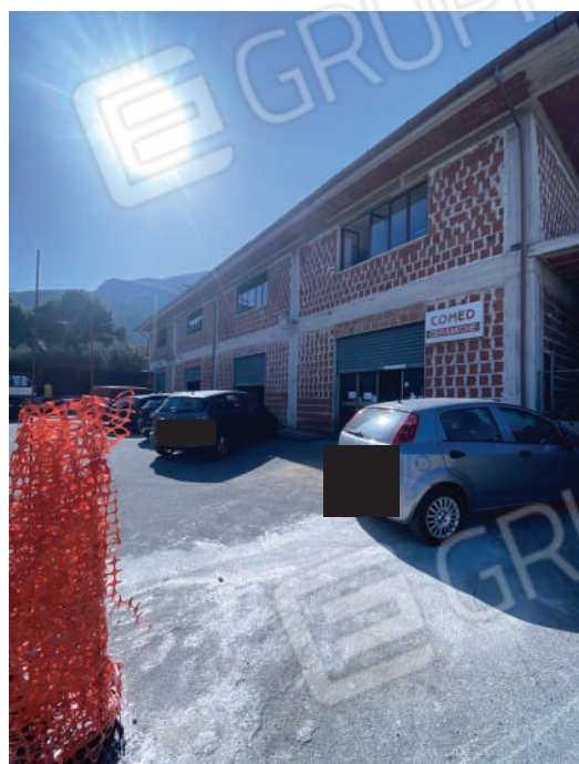
Foto 4. Piazzale piano seminterrato.
