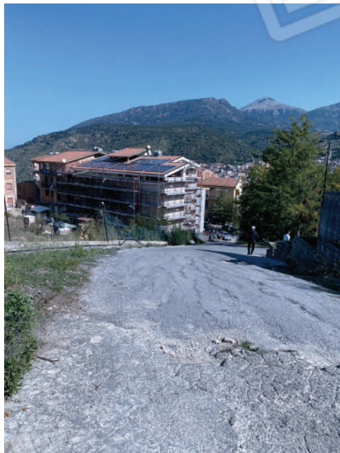
Foto 1. Strada di accesso al lotto.
