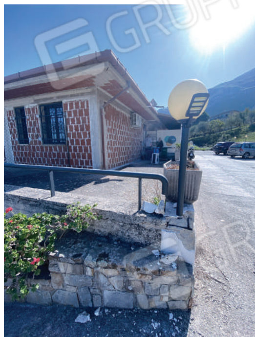
Foto 8. Prospetto laterale e piazzale piano terra.
