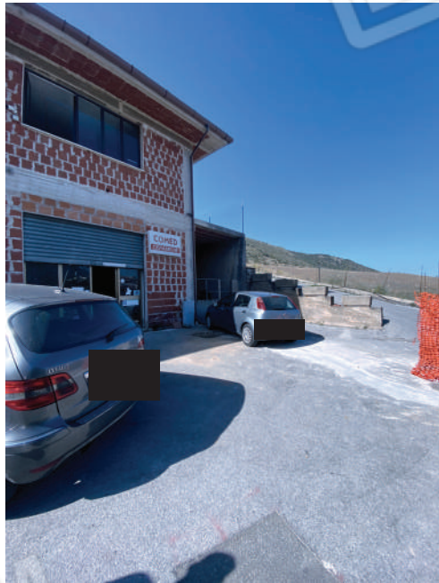
Foto 29. Piano seminterrato, piazzale.
