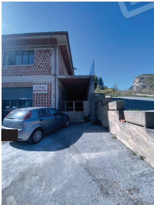
Foto 5. Piazzale piano seminterrato.
