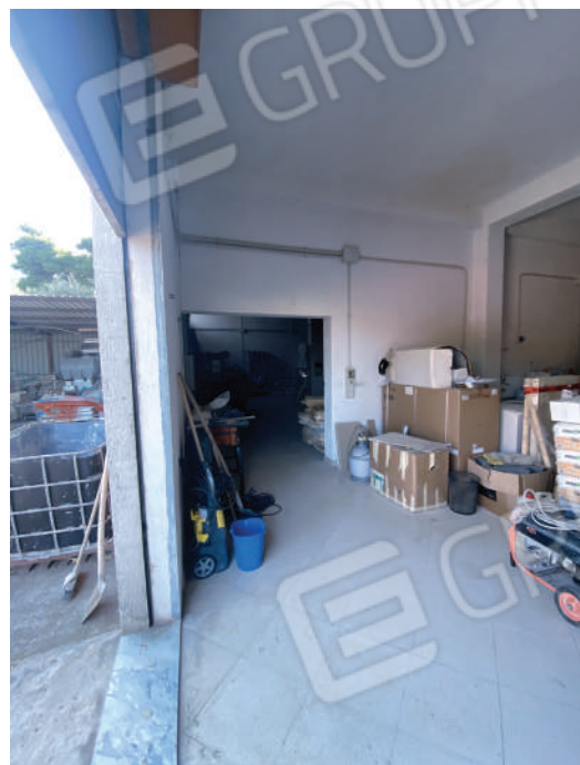
Foto 16. Piano seminterrato, Vano 2.
