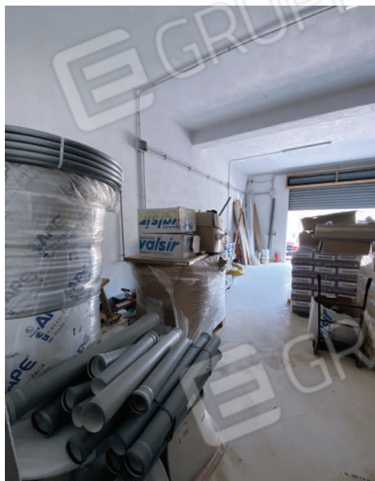
Foto 24. Piano seminterrato, Vano 2.
