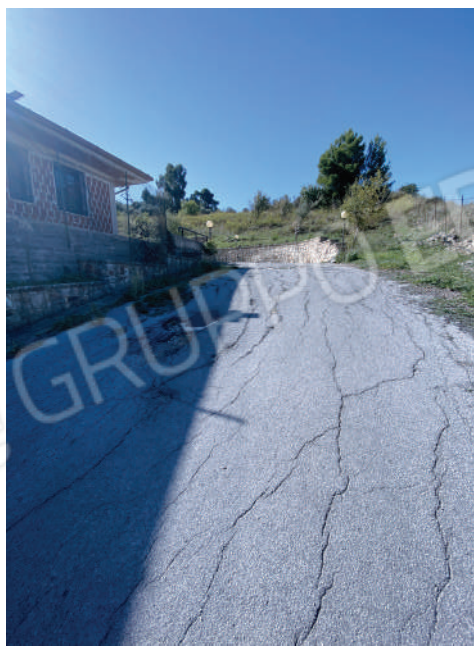
Foto 6. Strada di accesso al lotto.
