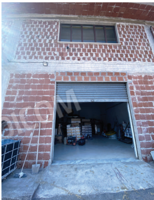
Foto 15. Accesso piano seminterrato.
