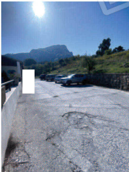
Foto 9. Piazzale piano terra.
