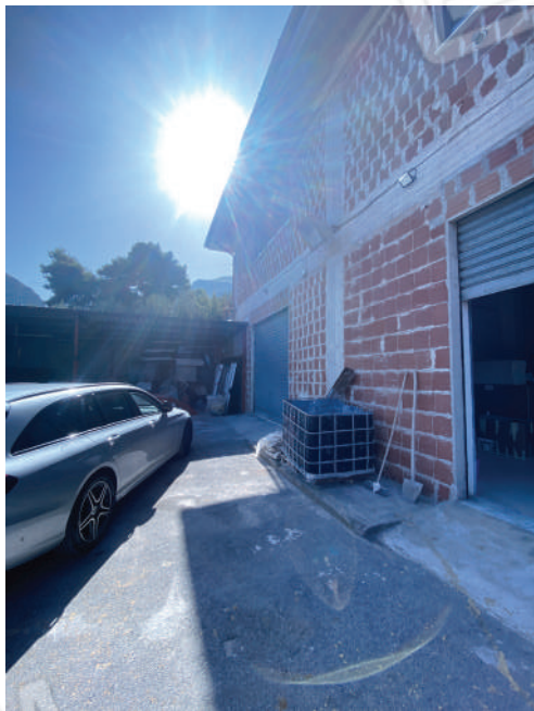
Foto 13. Accesso piano seminterrato.
