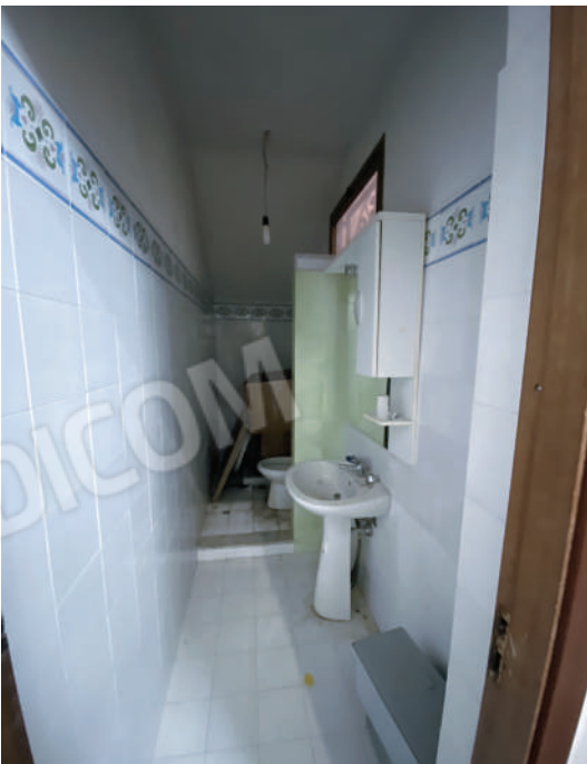
Foto 23. Piano seminterrato, Vano 2, wc.
