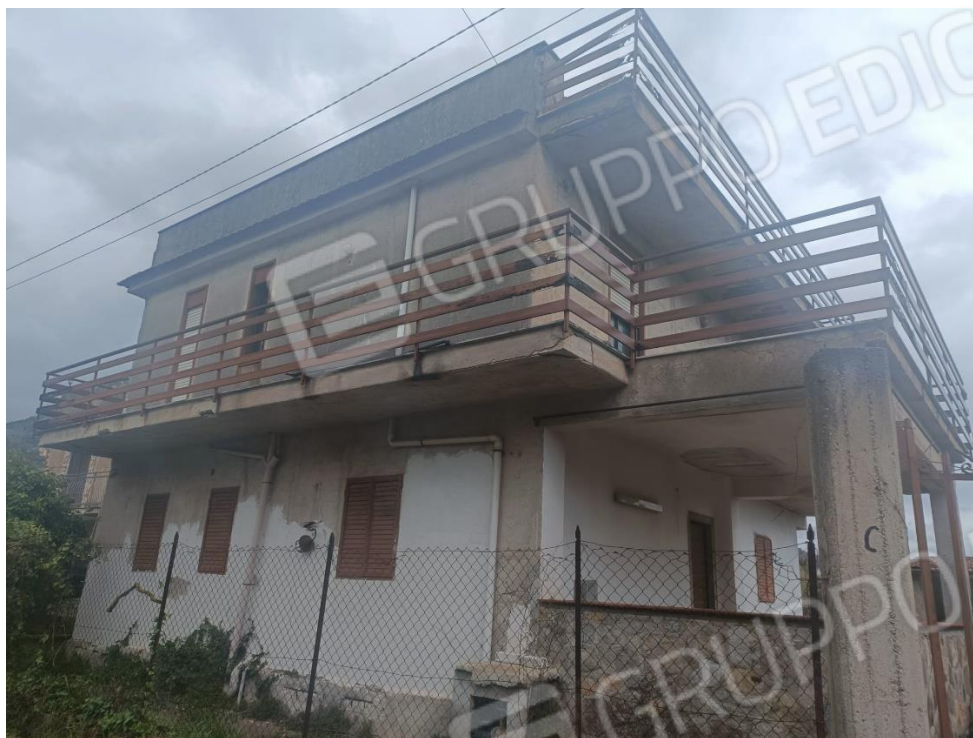
Foto 1-2. Viste esterne del fabbricato.
