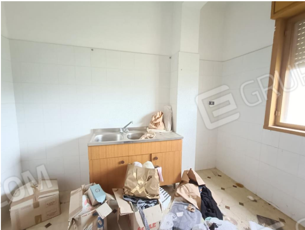
Foto 14. Appartamento di piano primo (sub. 3): cucina
