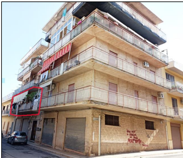
Prospetto Intero immobile
