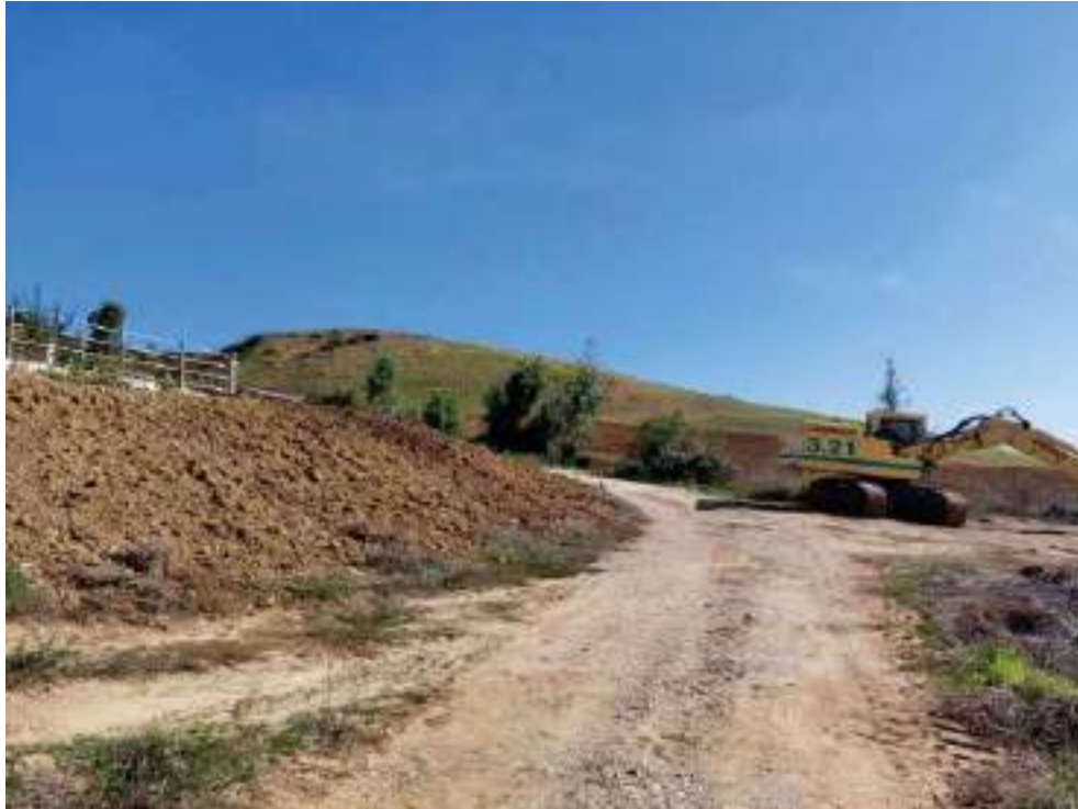
Foto 4 – Accesso al corpo “A”
