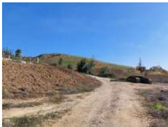
Foto 4 – Accesso al corpo "A"
