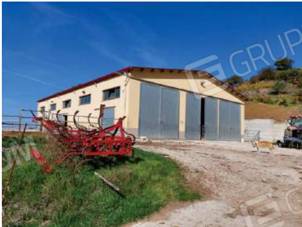
Foto 11 – Corte di pertinenza Corpo "A"
