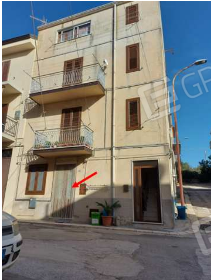
Foto 5 – Prospetto principale su Via Lazio Indicazione dell’accesso all’ambiente soggiorno
