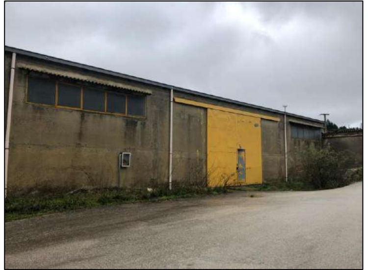
capannone ricovero automezzi
