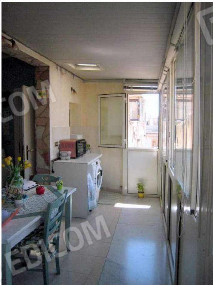
Foto n. 32-33. La veranda chiusa da pannelli in vetro e struttura in alluminio anodizzato; la copertura è con pannelli sandwich.
