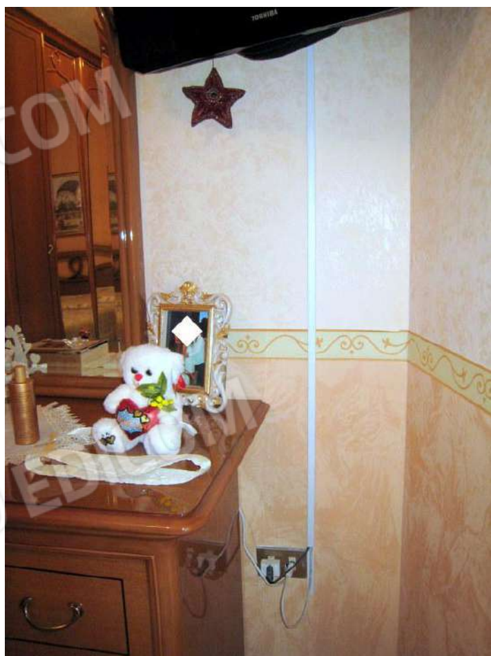
Foto n. 25. Dettaglio di condutture "volanti" in camera da letto.
