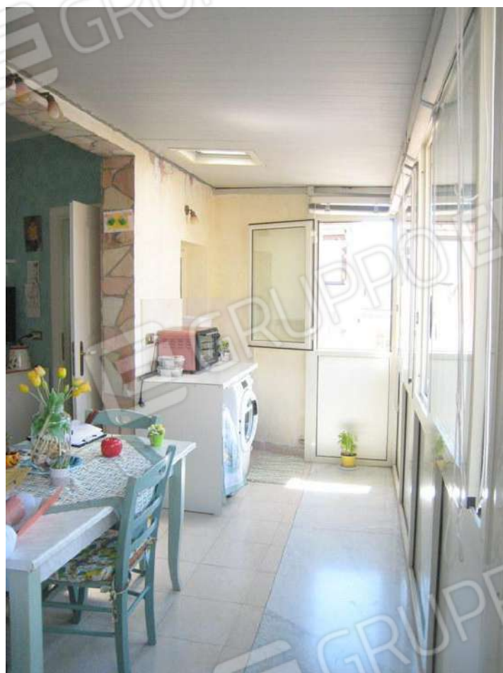
Foto n. 32-33. La veranda chiusa da pannelli in vetro e struttura in alluminio anodizzato; la copertura è con pannelli sandwich.
