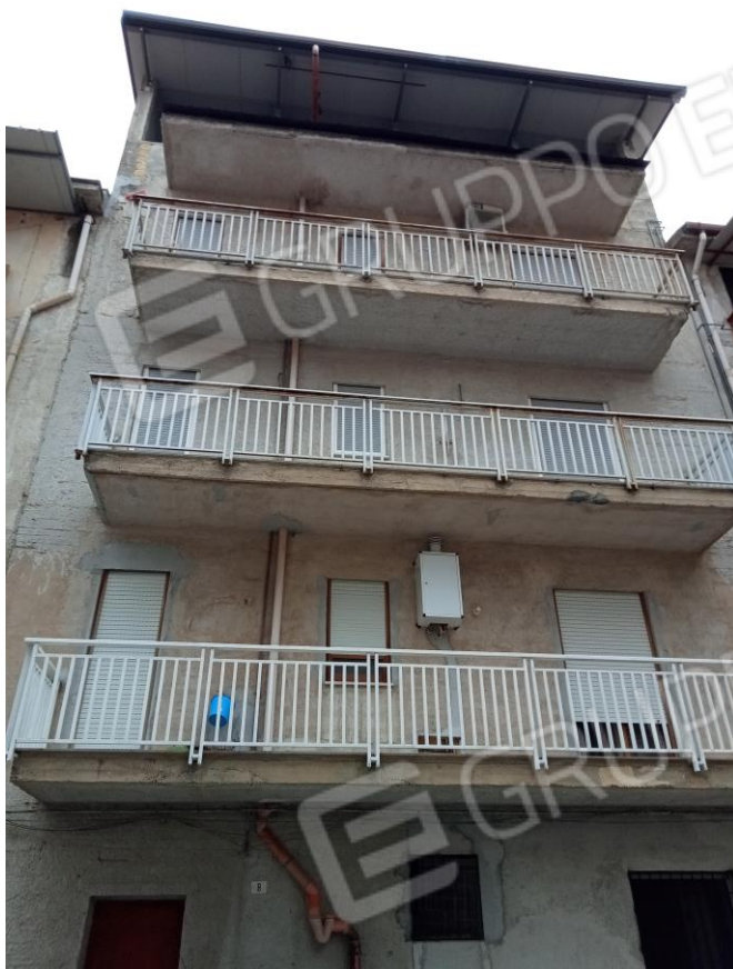
Foto 3: "Prospetto secondario intero fabbricato della Via Tindari"
