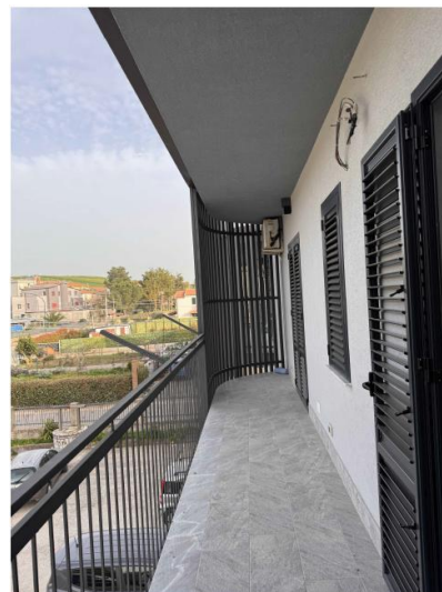
16 - vista del balcone lato Sud
