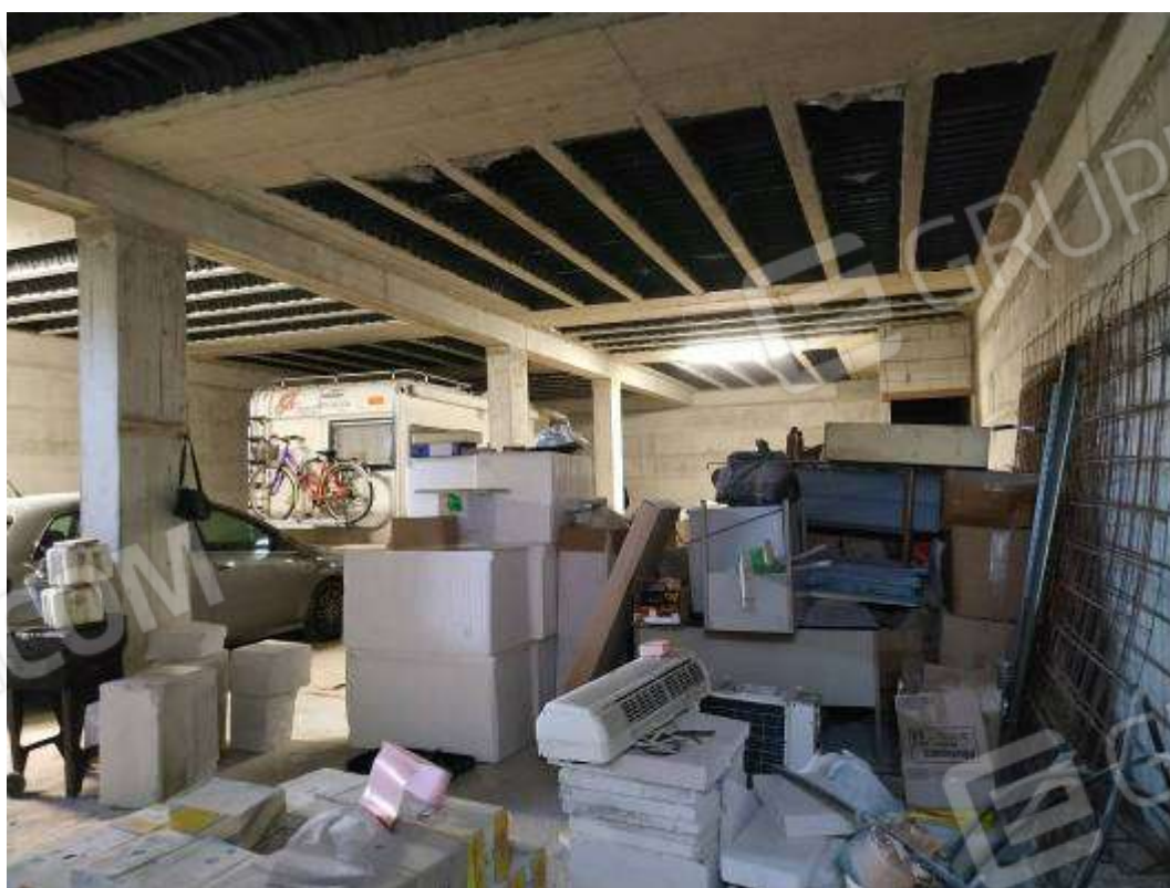
IMG 8_Magazzino, angolo Sud-Ovest
