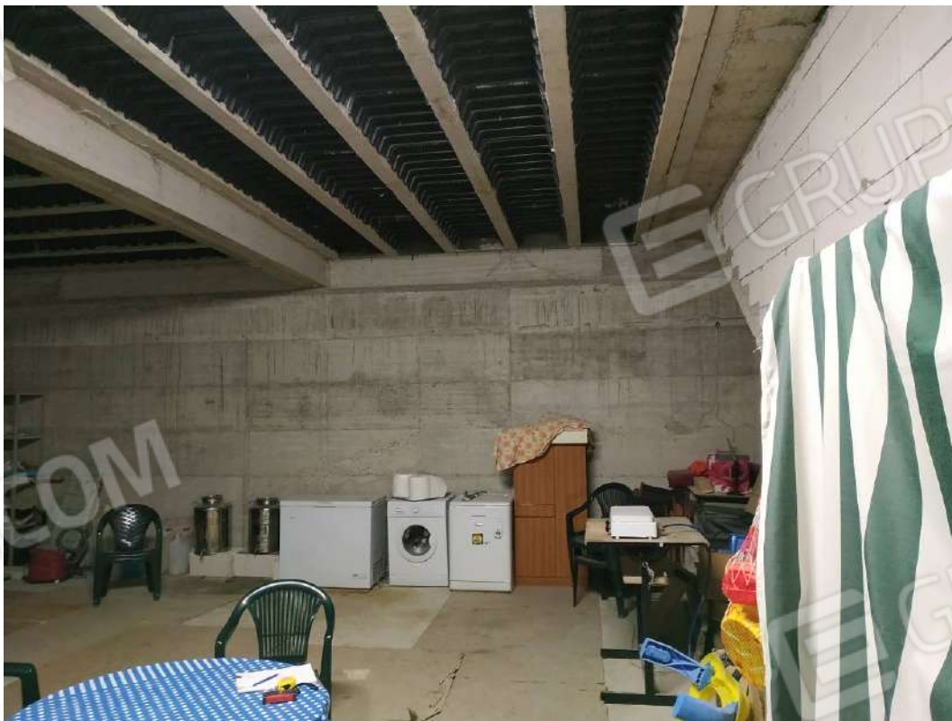
IMG 12_Lato Sud
