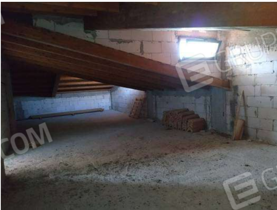
IMG 48_Lato Nord-Est
