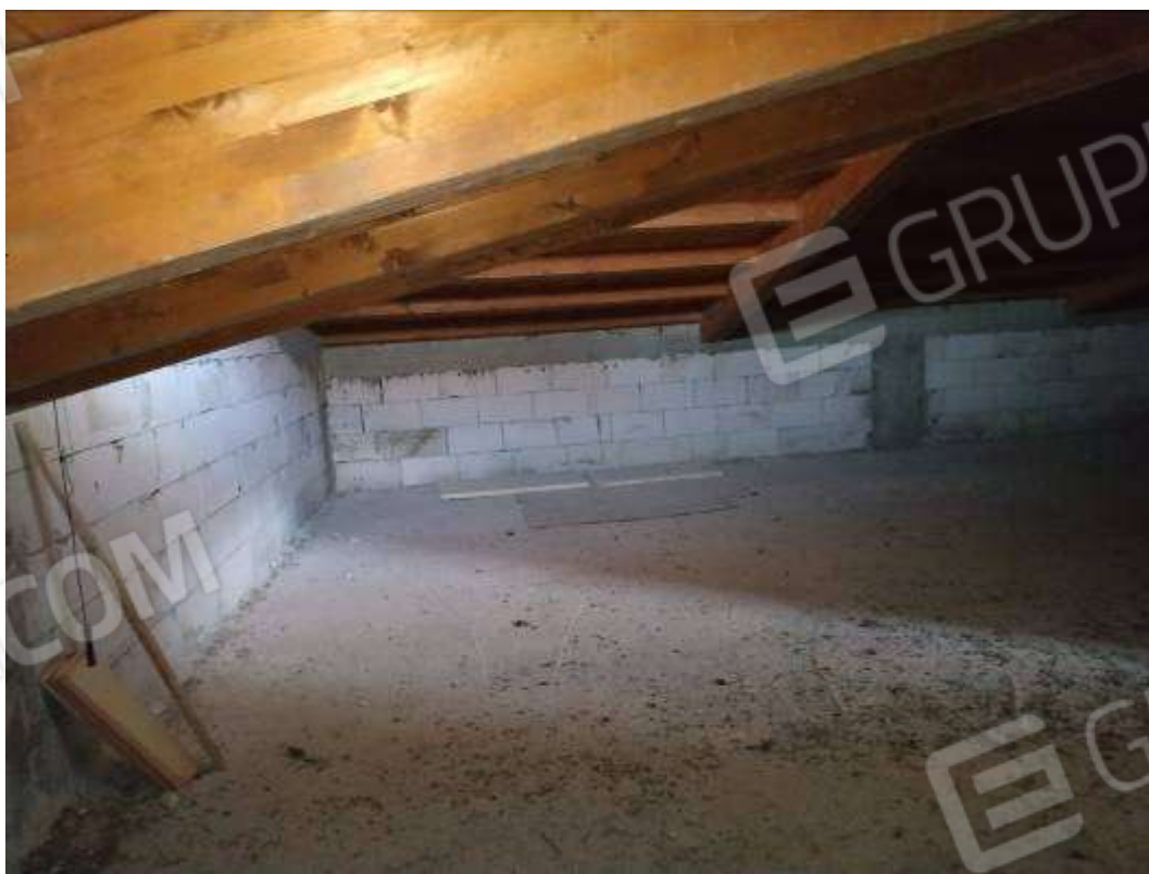
IMG 58_Lato Nord
