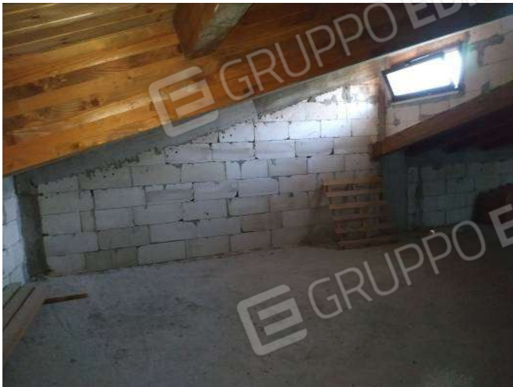
IMG 49_Lato Sud-Ovest
