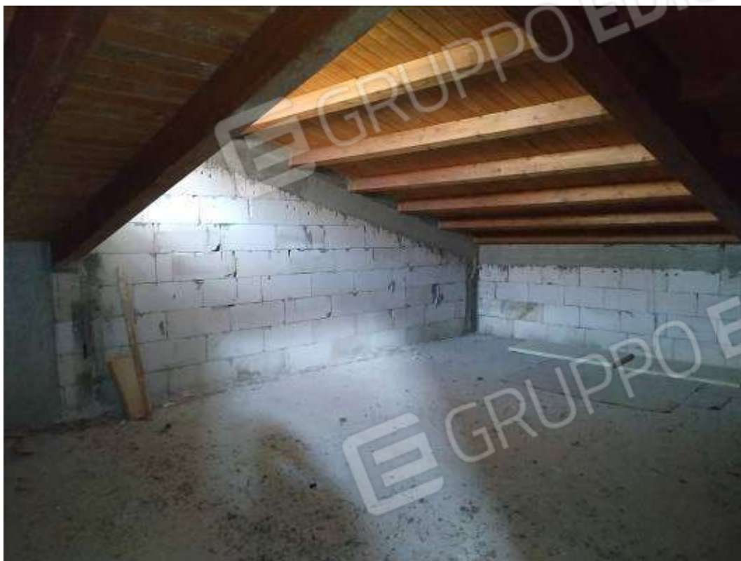
IMG 57_Accesso sottotetto
