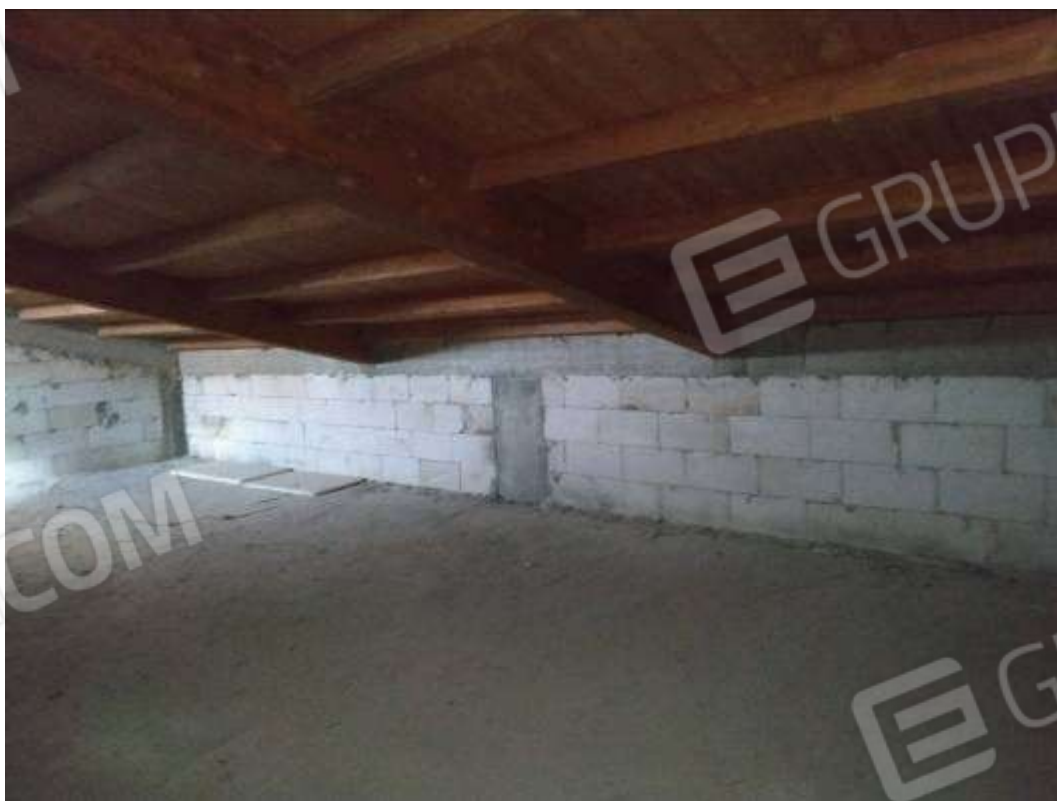
IMG 44_Lato Nord-Est
