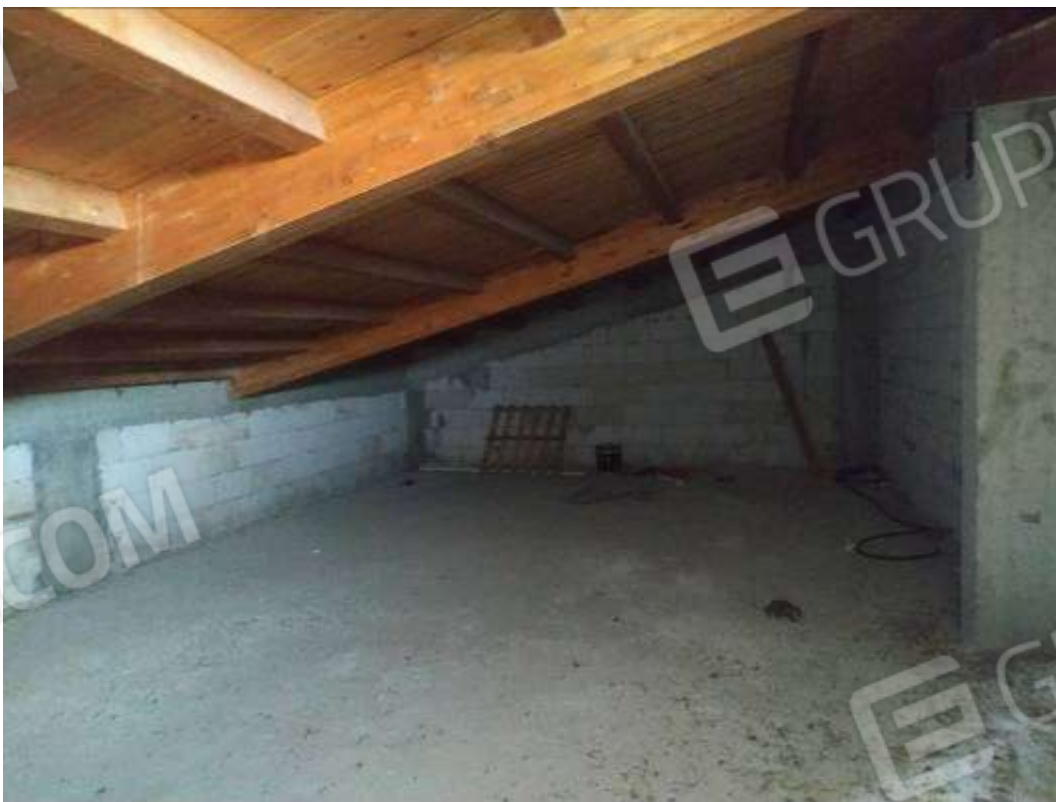
IMG 42_Lato Nord-Est
