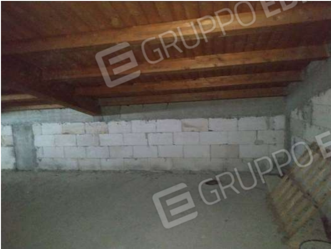
IMG 45_Lato Nord-Est
