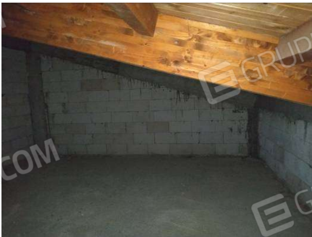
IMG 52_Lato Sud-Ovest
