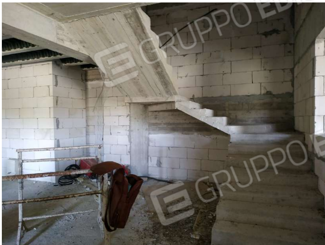
IMG 13_Scala di collegamento con piano primo
