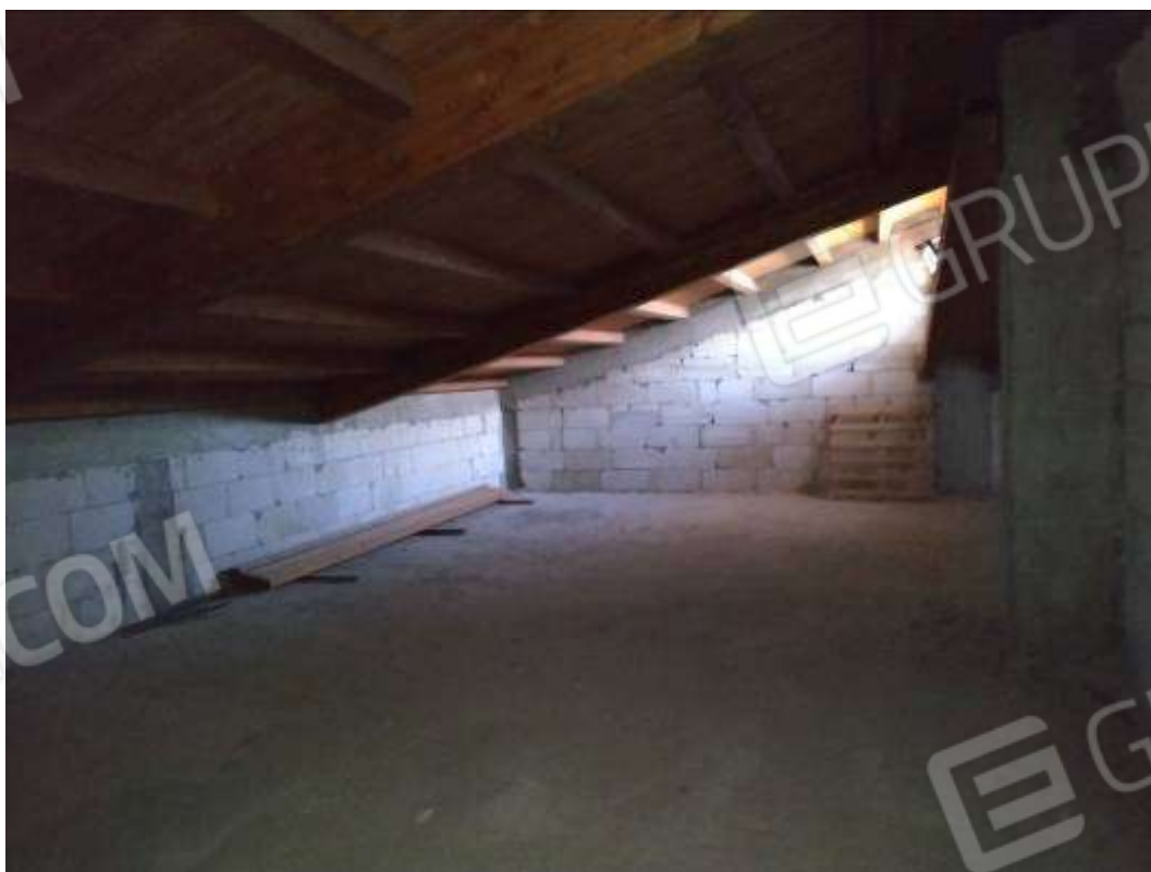
IMG 54_Lato Sud-Ovest
