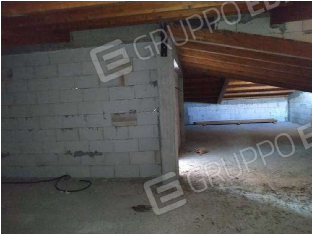
IMG 47_Lato Nord-Est
