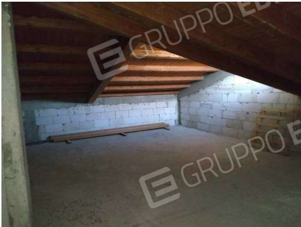
IMG 55_Accesso sottotetto
