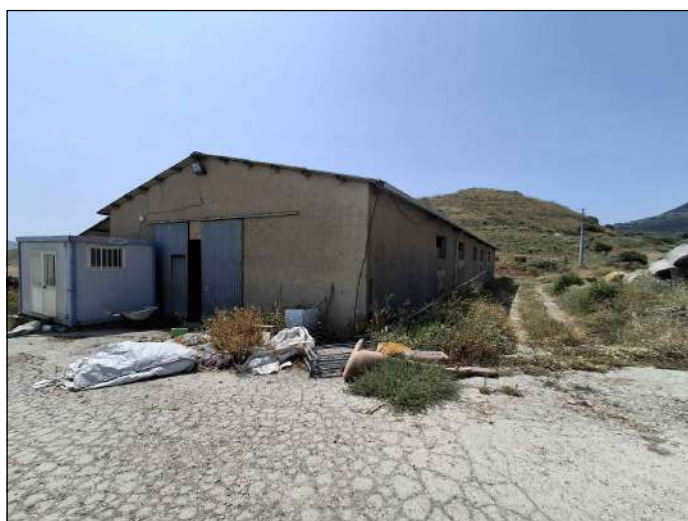
prospetto nord-ovest- stalla, vista dalla corte
