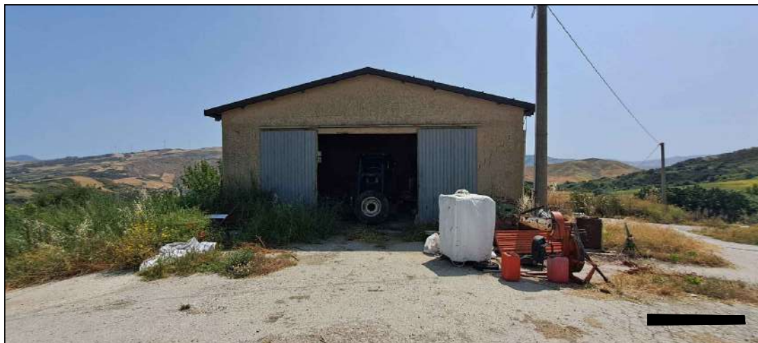
prospetto ovest- fienile
