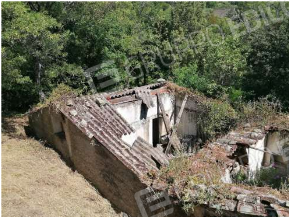
VISTA INTERNO CAMERA CENTRALE
