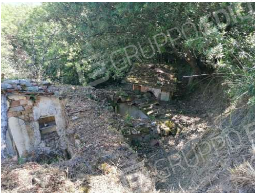
COPERTURE LATO EST E PORTICO
