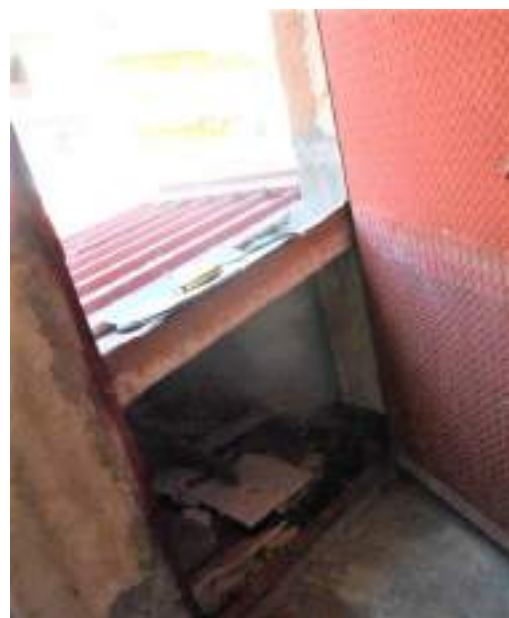
5. Il sottotetto determinatosi dalla copertura del lastrico solare ha un'altezza interna al colmo di 1,00 mt.
