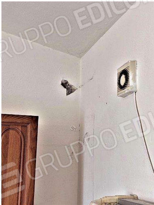
79 ed 80 = Abitazione di 3°P – vano Q (part. muffa da infiltrazione)
