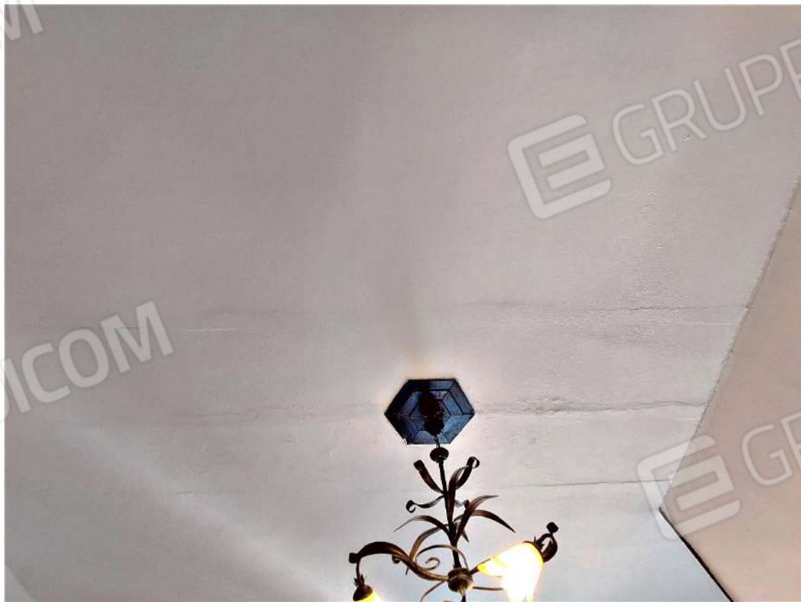
55 = Abitazione di 2°P – vano M (part. soffitto)
