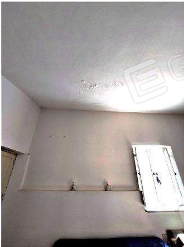
79 ed 80 = Abitazione di 3°P – vano Q (part. muffa da infiltrazione)
