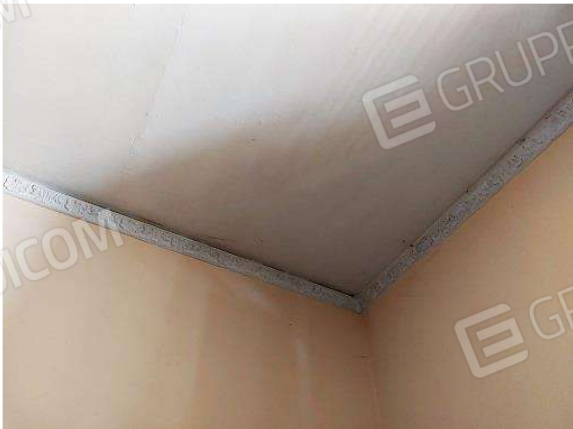
32 = Abitazione di 1°P – vano F (part. soffitto)
