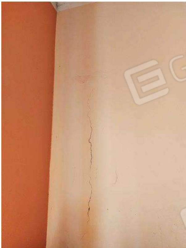
68 e 69 = Abitazione di 2°P – vano P (part. lesioni e muffa)
