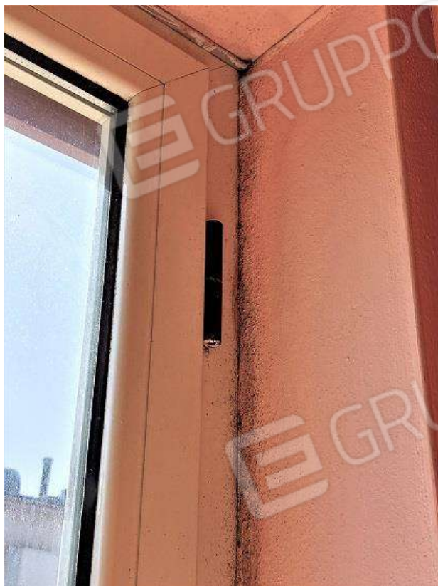
70 e 71 = Abitazione di 2°P – vano P (part. muffa)
