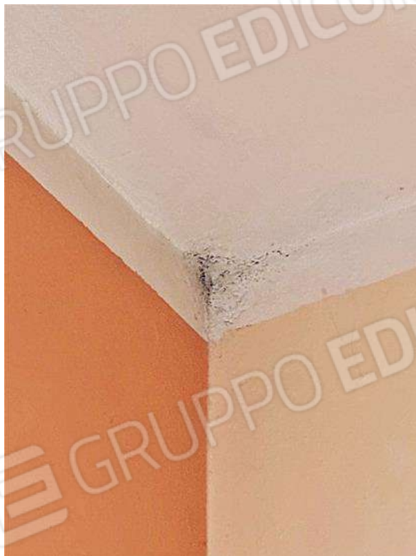
68 e 69 = Abitazione di 2°P – vano P (part. lesioni e muffa)
