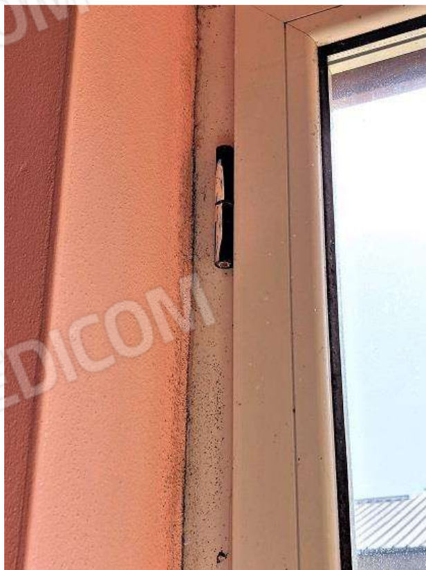
70 e 71 = Abitazione di 2°P – vano P (part. muffa)
