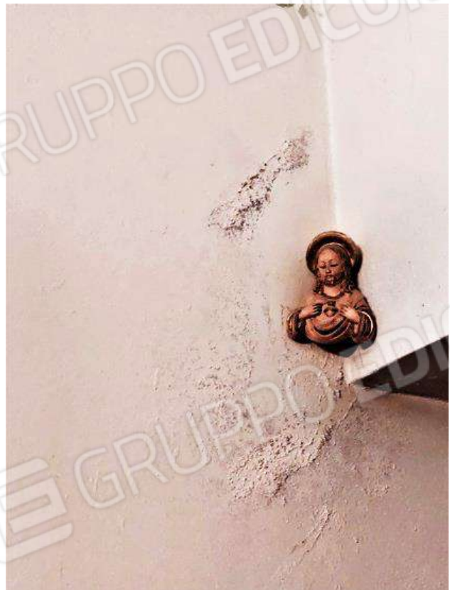
62 e 63 = Abitazione di 2°P – vano O (part. muffa)
