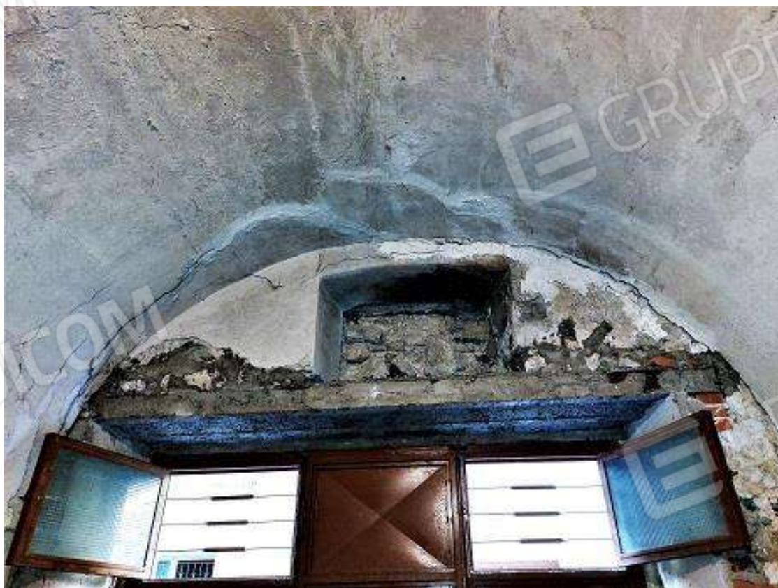
28 = Magazzino di P.T. – vano E (part. architrave)
