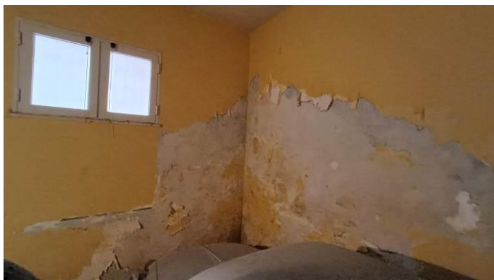
Ambiente 3 - Ammaloramento da infiltrazione
