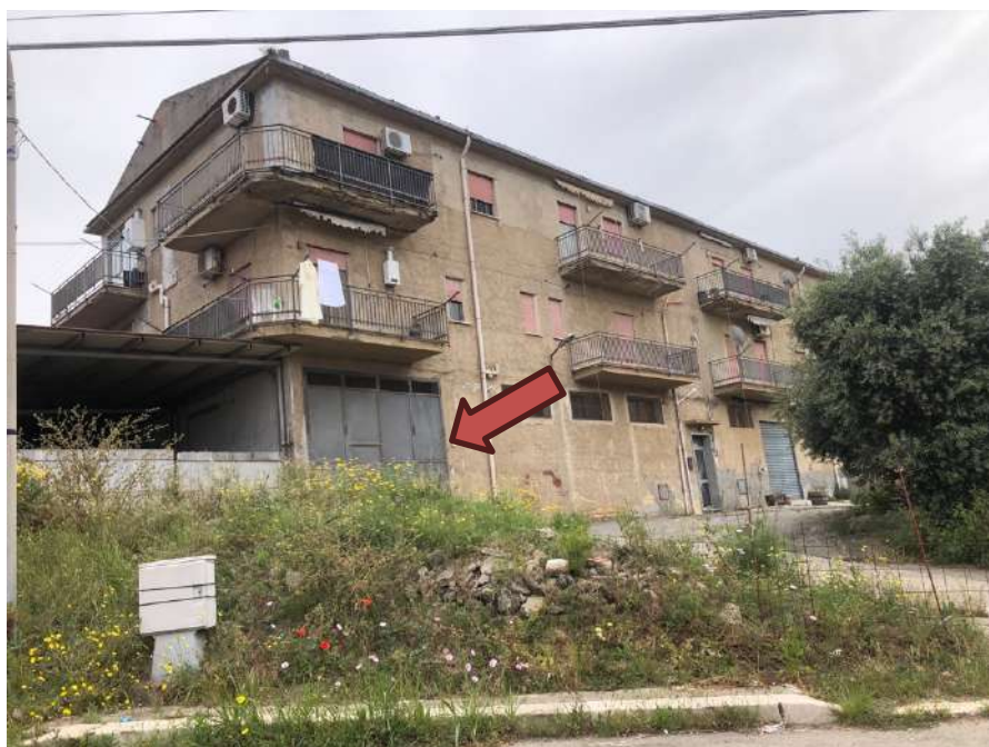
2. Panoramica del fabbricato dalla via Kennedy
