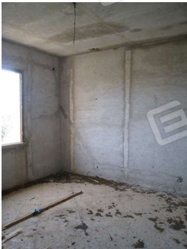
Foto n. 137-138. Percolazioni d'acqua all'interno di quasi tutti gli ambienti.
