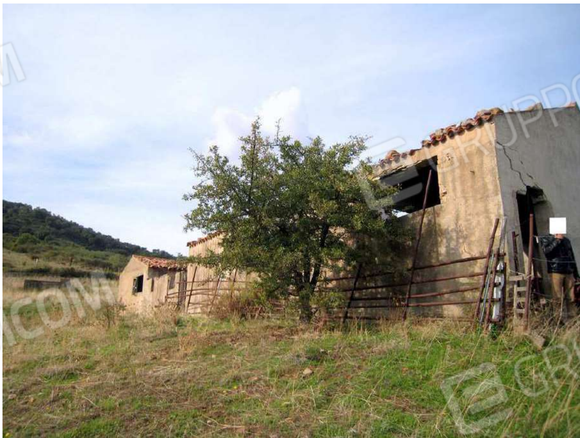
Foto n. 144. Il fabbricato distinto con la p.lla 383. Sul prospetto sono ben visibili delle lesioni.
