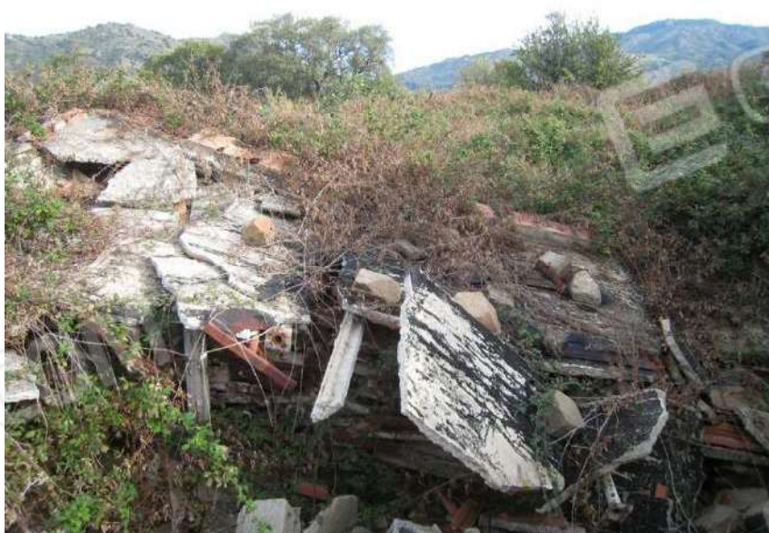
Foto n. 155. Porzioni di tetto già crollate.
