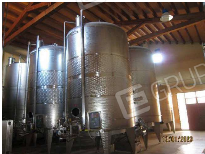
Foto n. 30. La grande sala stoccaggio.
