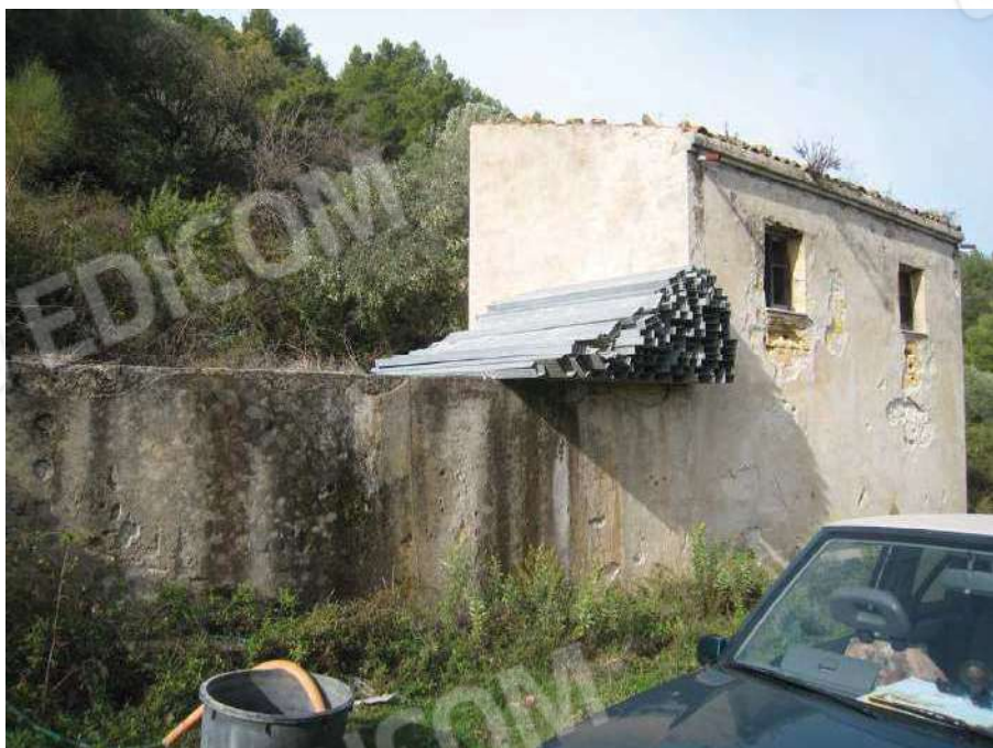
Foto n. 21. Fabbricato rurale identificato dalla p.lla 595 è stato elevato sopra una vasca di riserva idrica.
