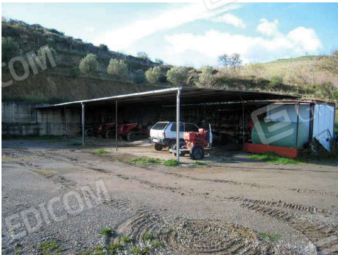
Foto n. 11. Tettoia abusiva realizzata sulle p.lle 610 e 17. Nella successiva fotografia è segnalata da una freccia gialla.
