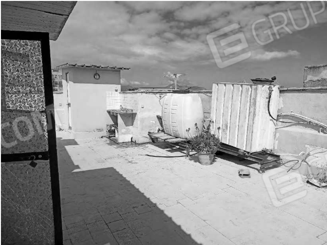
Fotografia 22 – Bene n. 2 – Lastrico solare
