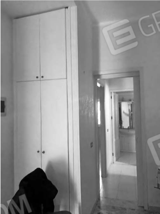
Fotografia 15 – Bene n. 1 – Disimpegno Lotto UNICO – Immobile identif. al N.C.E.U. del Comune di Ficarazzi (PA), fg. n.1, part. n. 359, sub. n. 3
