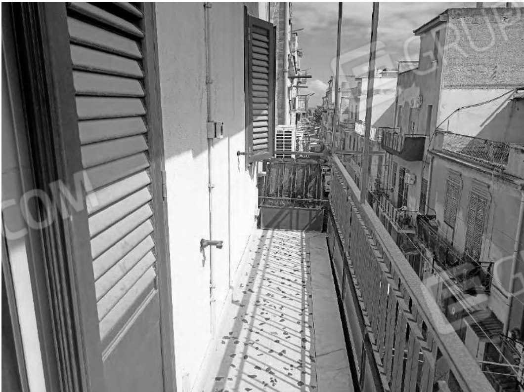
Fotografia 14 – Bene n. 1 – Balcone prospiciente via Mare
