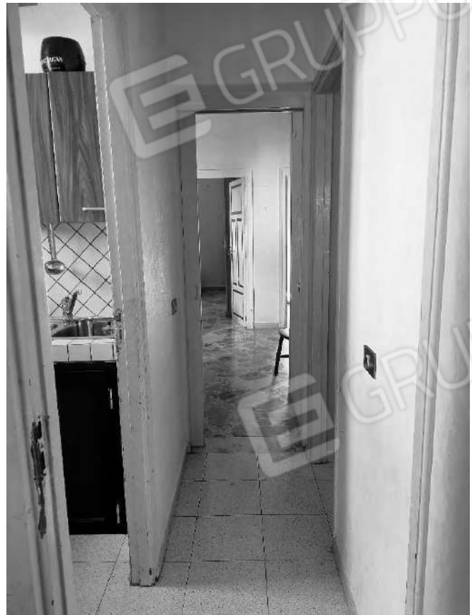
Fotografia 16 – Bene n. 1 – Disimpegno Lotto UNICO – Immobile identif. al N.C.E.U. del Comune di Ficarazzi (PA), fg. n.1, part. n. 359, sub. n. 3
