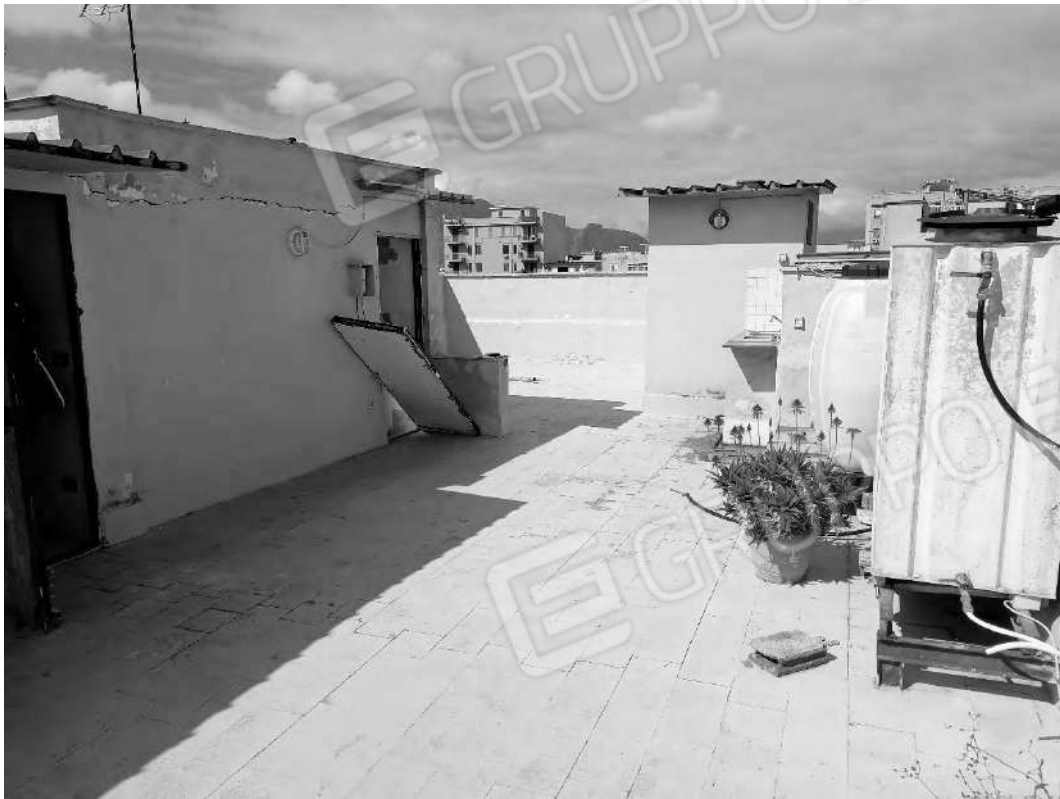
Fotografia 21 – Bene n. 2 – Lastrico solare
