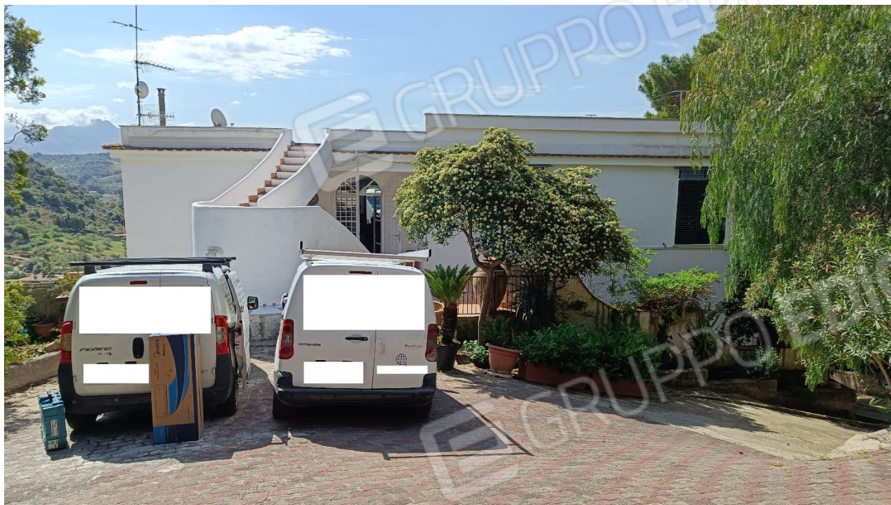
Foto 3 – Prospetto posteriore dell'edificio
