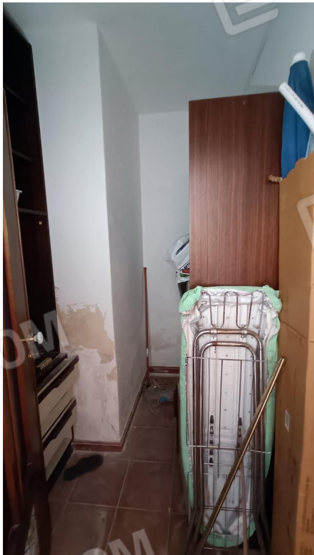
Foto 21 – Ripostiglio con vista interna
