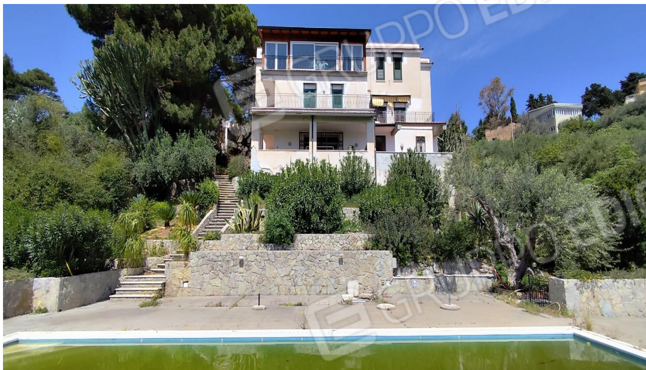
Foto 25 – Prospetto posteriore visto dalla piscina
