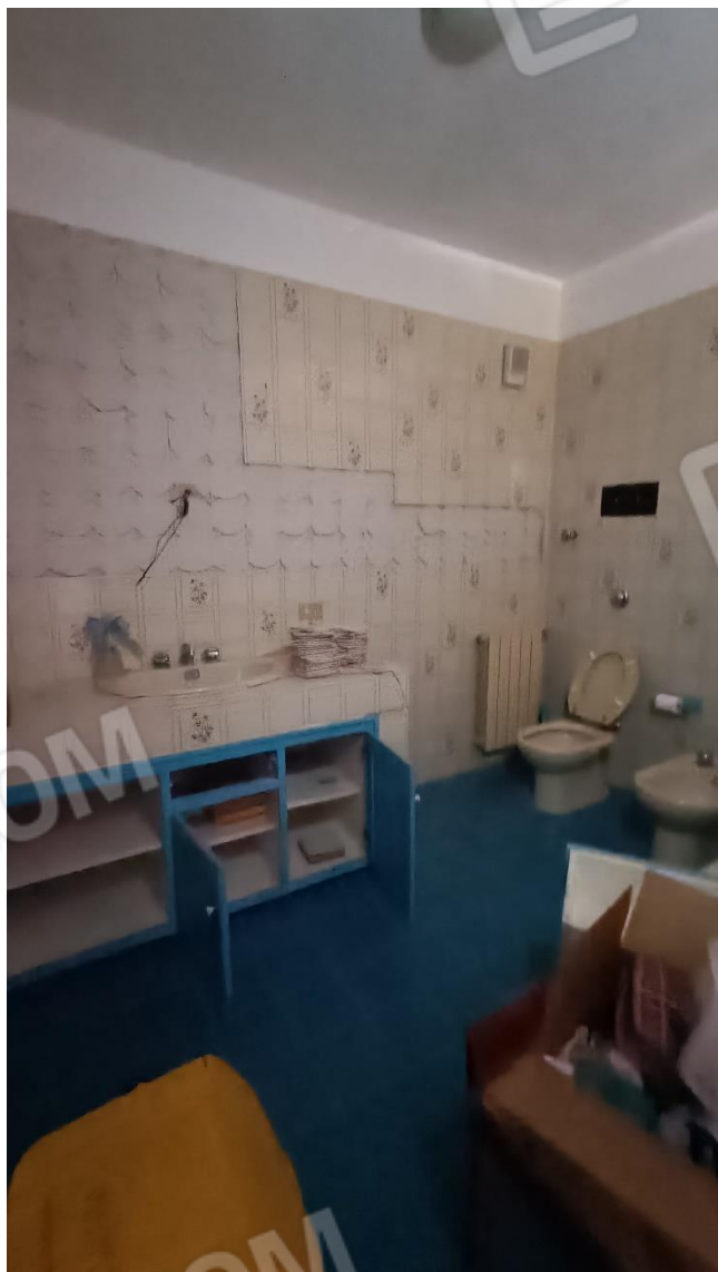
Foto 17 – Bagno con vista interna
