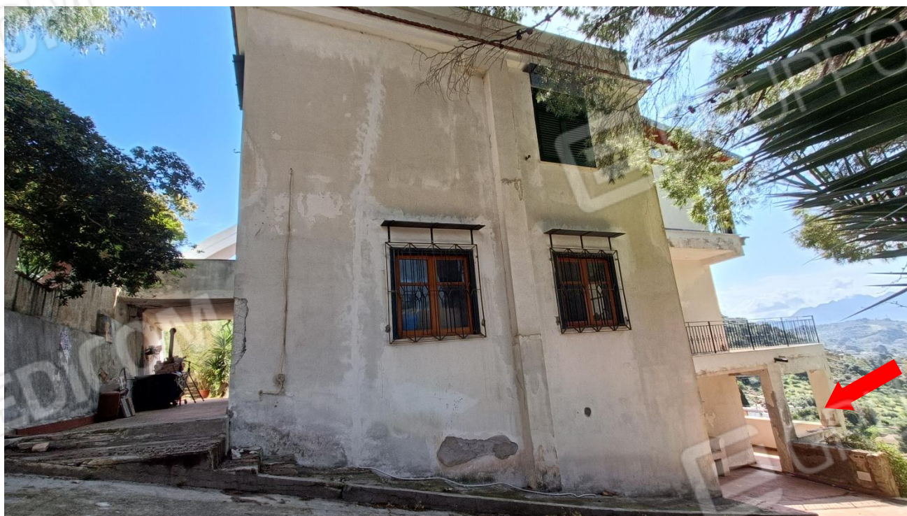
Foto 4 – Prospetto laterale dell'edificio
