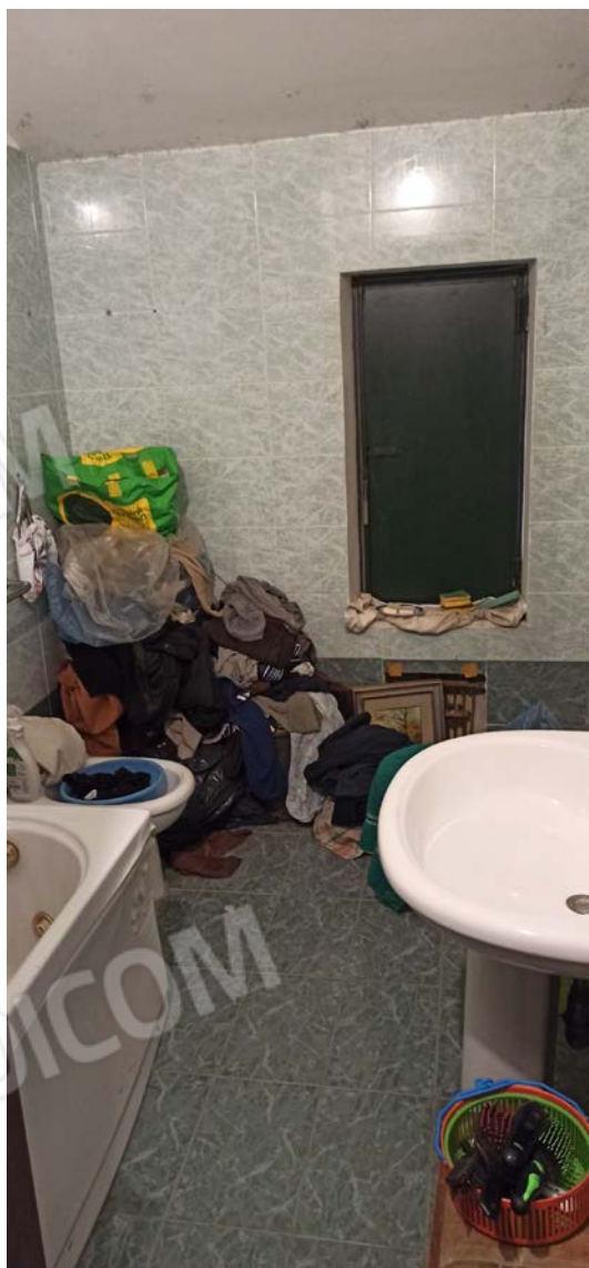
14 – Piano 1° - Vano w.c.
