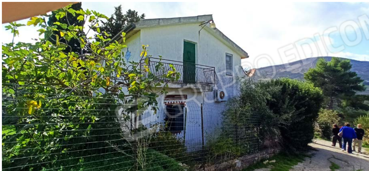
Foto n. 3 – Zona di accesso
