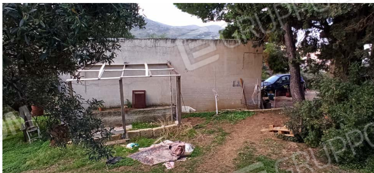
Foto n.20 – Locale di sgombero/magazzino
