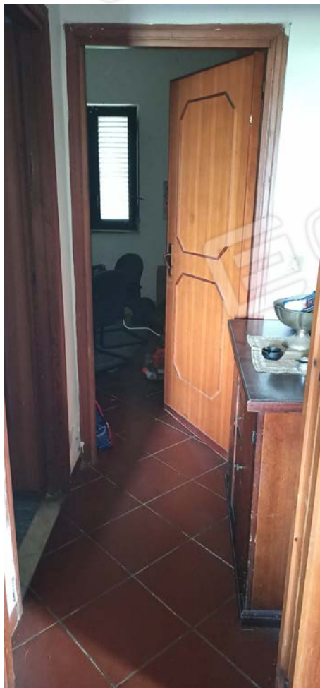
Foto n.9 – Piano Terra – Disimpegno
