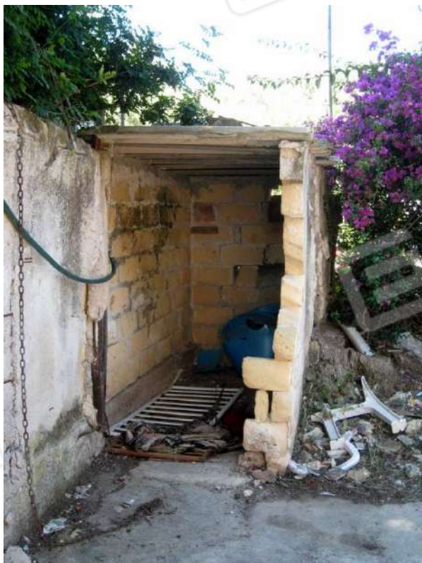
Foto n. 8. Il piccolo ripostiglio sulla corte che va demolito.
