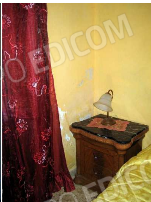
Foto n. 23. Sempre la camera da letto matrimoniale posta alle spalle del soggiorno. Foto n. 24. Umidità ascendente nella stessa stanza.
