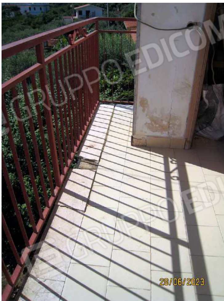
Foto n. 41-42. Pilastri ammalorati e pavimentazione disconnessa sul pavimento del portico.
