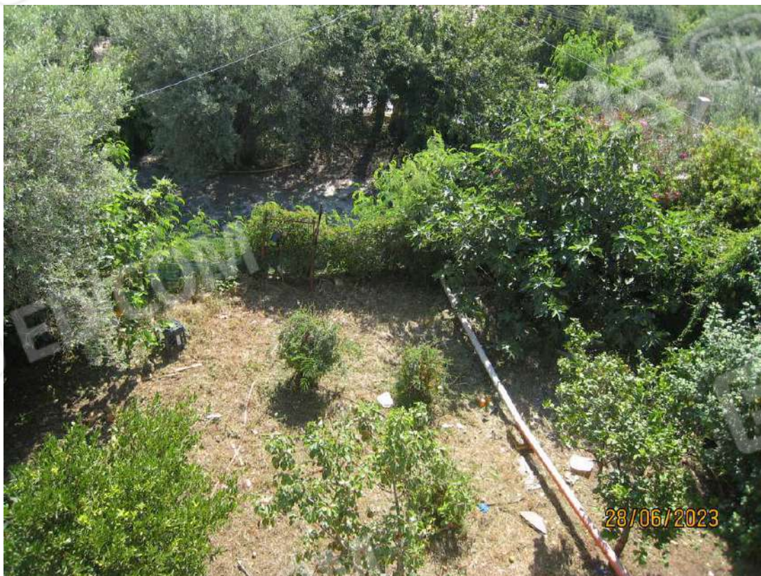
Foto n. 13. La condotta fuori terra dei reflui domestici ed il giardino.
