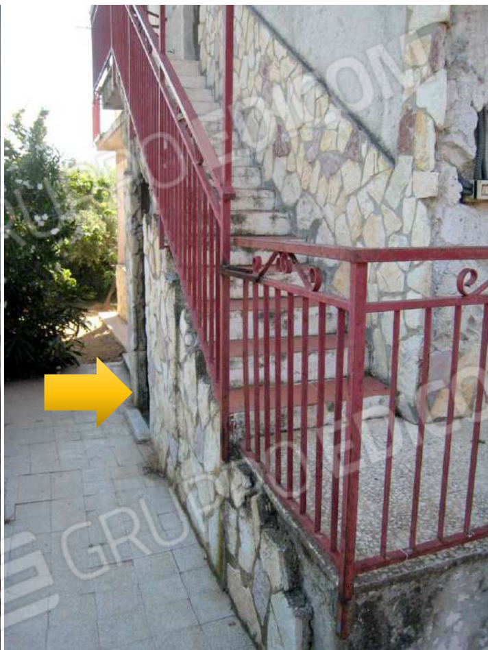
Foto n. 14-15. La scala che conduce al primo piano. Il sottoscala è stato chiuso abusivamente per ricavare un ripostiglio.
