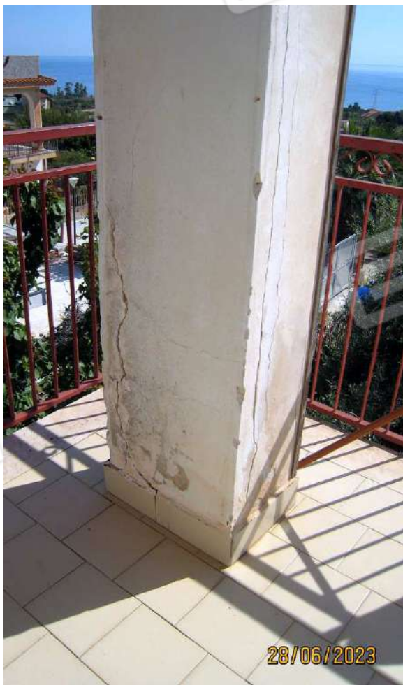
Foto n. 41-42. Pilastri ammalorati e pavimentazione disconnessa sul pavimento del portico.
