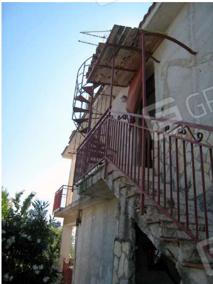
Foto n. 14-15. La scala che conduce al primo piano. Il sottoscala è stato chiuso abusivamente per ricavare un ripostiglio.
