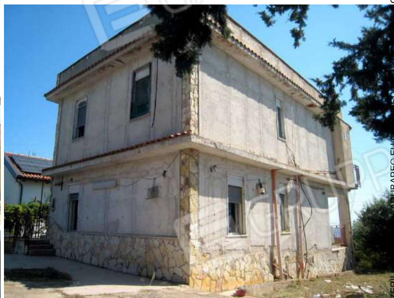
Foto n. 11. Prospetto lato monte e prospetto lato Termini Imerese.
