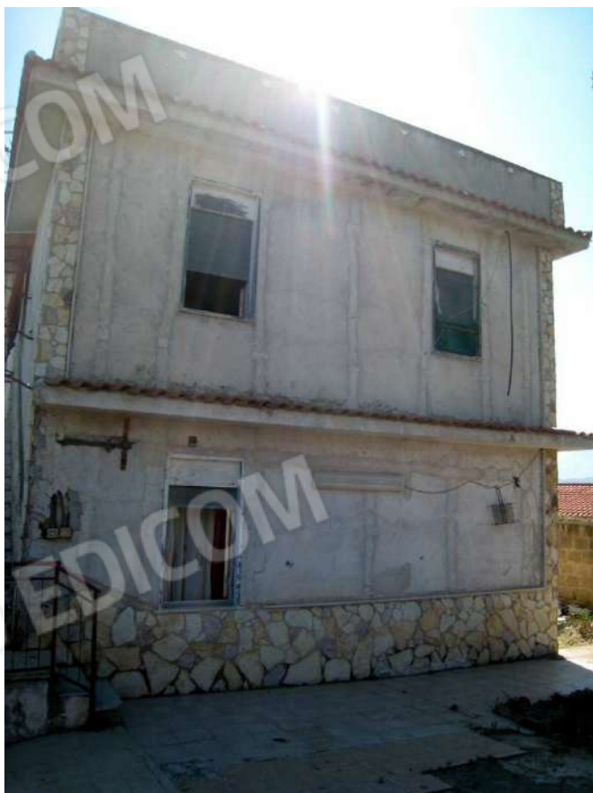
Foto n. 10. Il prospetto lato monte.
