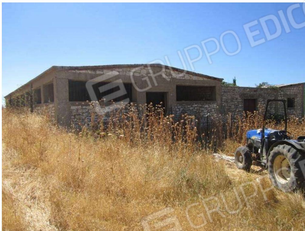
Allegato 5.63: fabbricato rurale (fg 107 Corleone part. 261)
