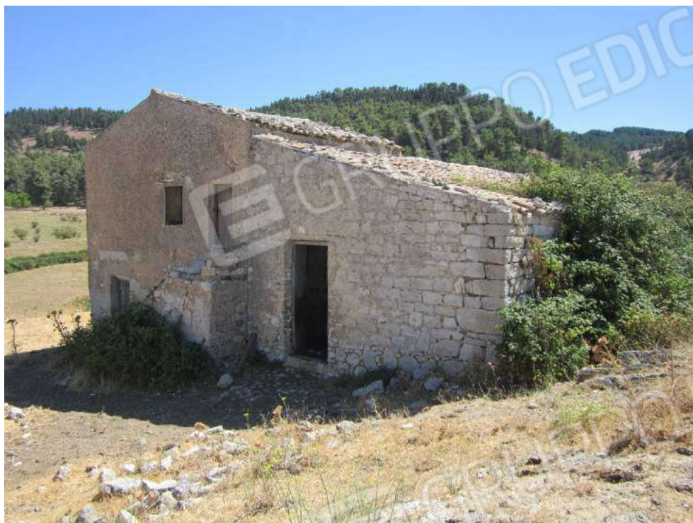
Allegato 5.59: fabbricato rurale (fg 107 Corleone part. 211)
