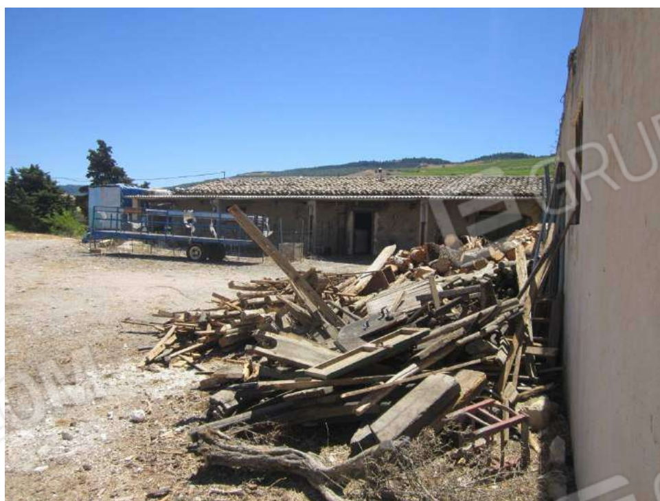
Allegato 5.34: porticato retrostante i locali agricoli
