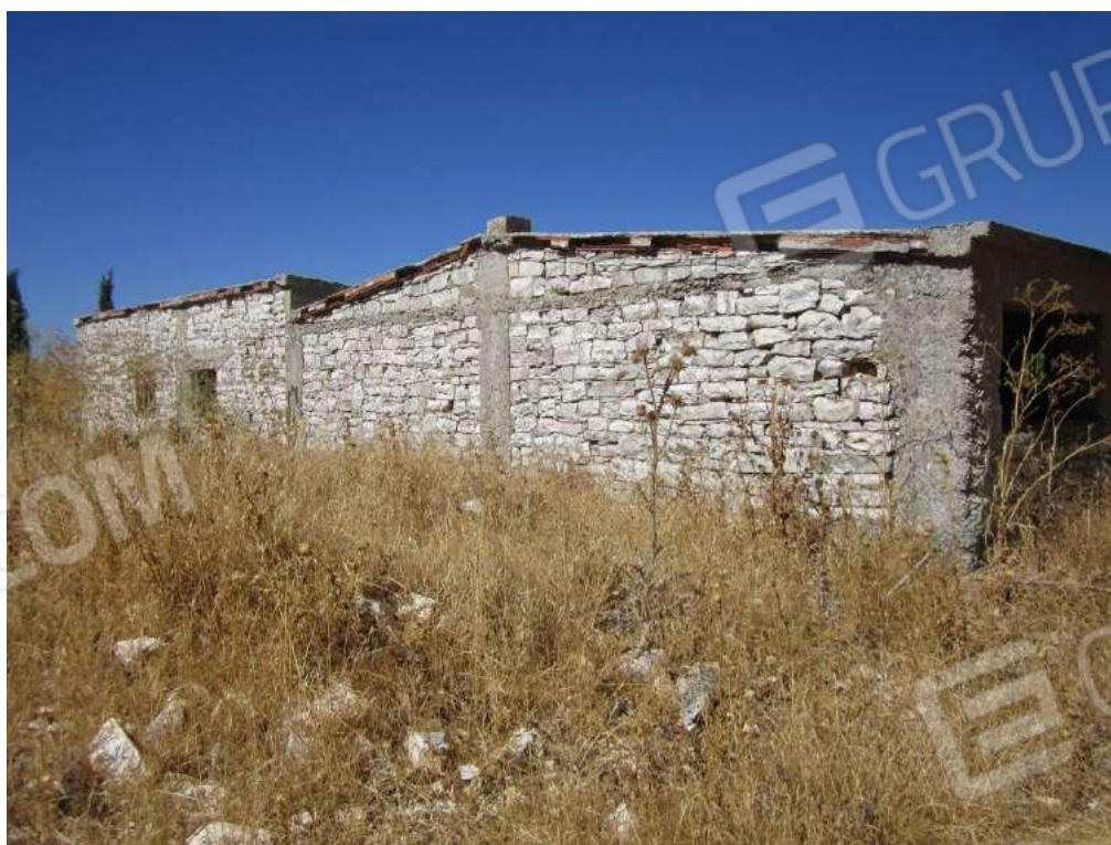
Allegato 5.64: fabbricato rurale (fg 107 Corleone part. 261)
