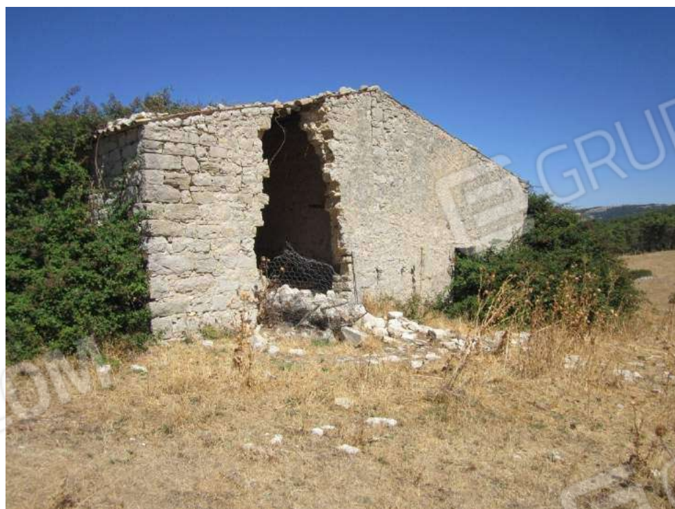
Allegato 5.60: fabbricato rurale (fg 107 Corleone part. 211)
