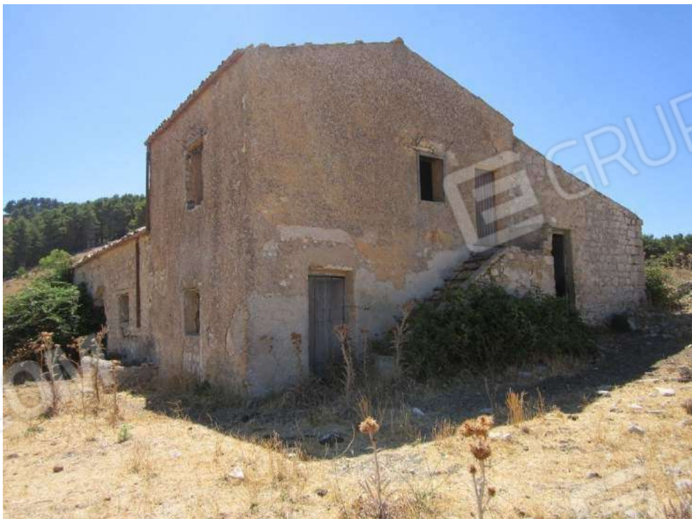
Allegato 5.58: fabbricato rurale (fg 107 Corleone part. 211)
