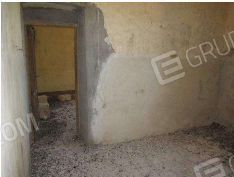
Allegato 5.20: ex locale di deposito
