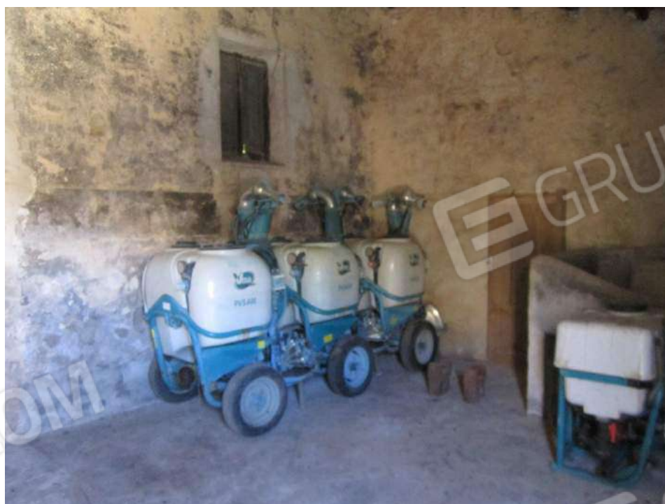
Allegato 5.22: ex locale di deposito
