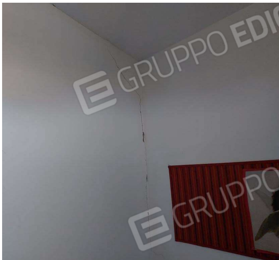
Foto dettaglio lesioni da cedimenti strutturali
