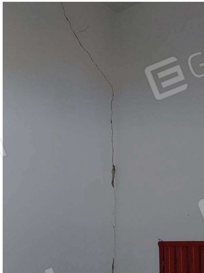
Foto dettaglio lesioni da cedimenti strutturali
