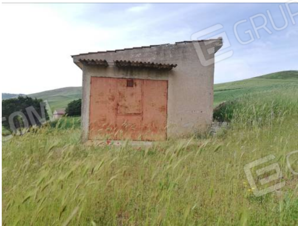
Foto n. 2 – Magazzino insistente sulla particella 80
