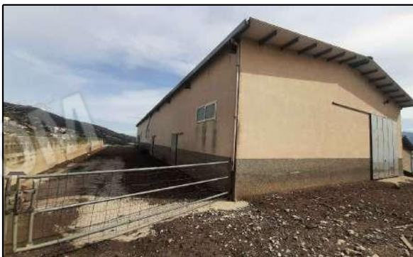
Esterno, vista laterale stalla - 12
