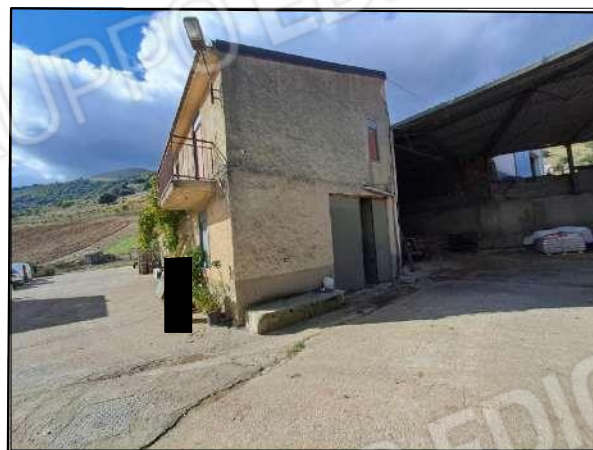
Magazzino 6 ,con soprastante abitazione
