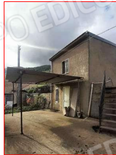
Esterno ingresso dal piano S1
