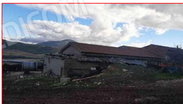
Esterno retrostante magazzino - 3
