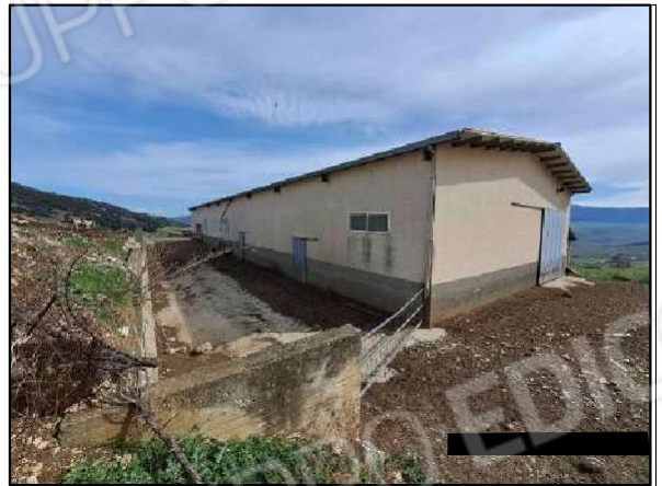
Esterno, vista laterale stalla - 12
