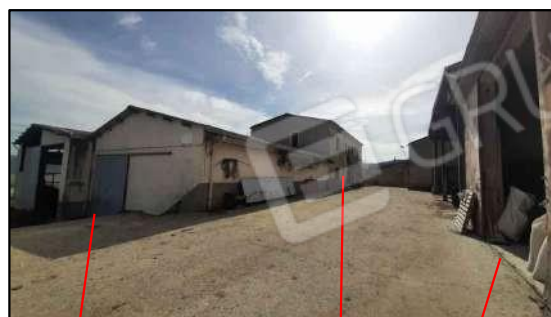
stalle - loc.dep.oggi abitazione - magazzino
