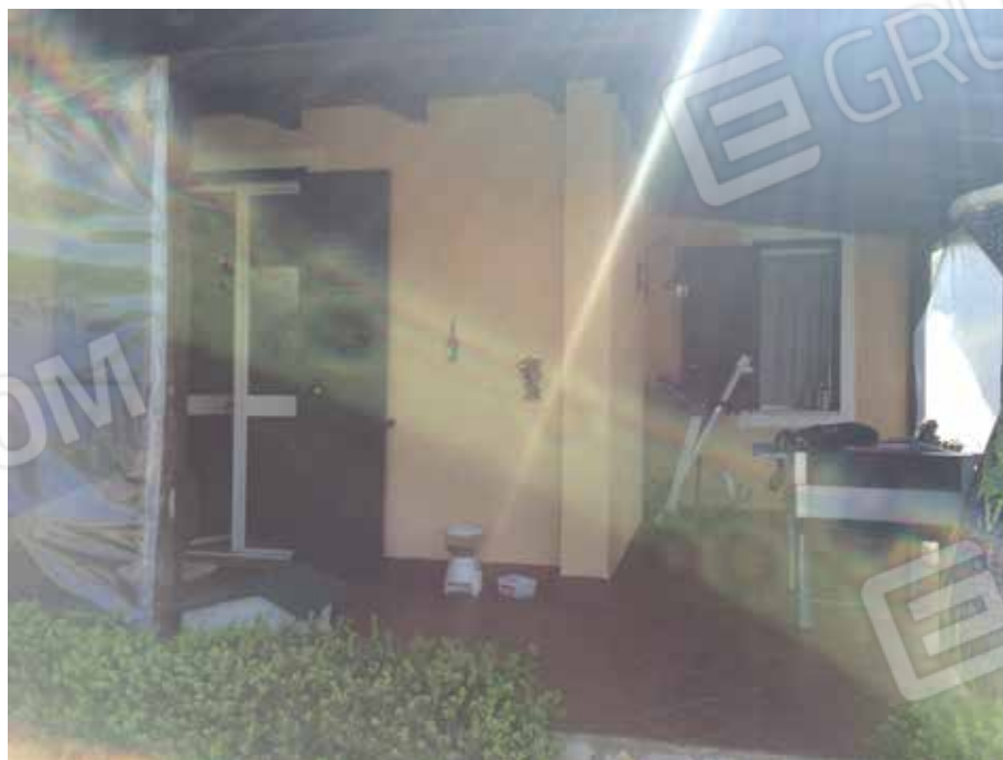
Foto 4. Portico sul prospetto principale.
