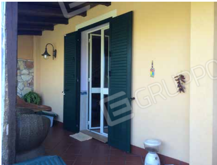
Foto 5. Portico sul prospetto principale.
