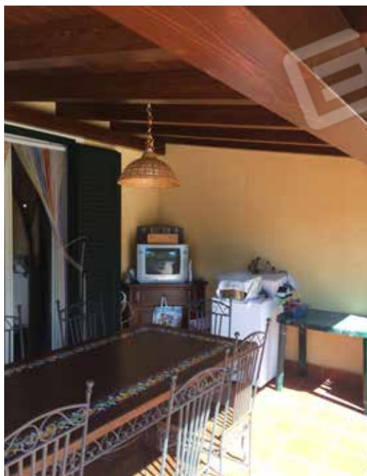
Foto 20. Portico sul prospetto retrostante.
