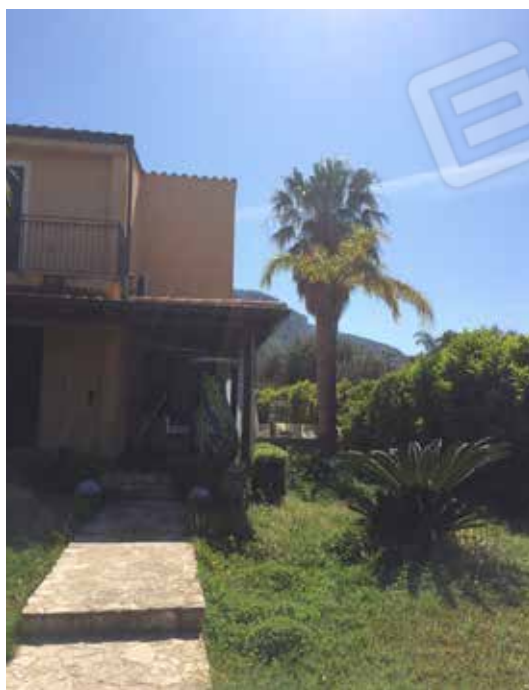
Foto 2. Corte, viottolo d'ingresso al piano terra.
