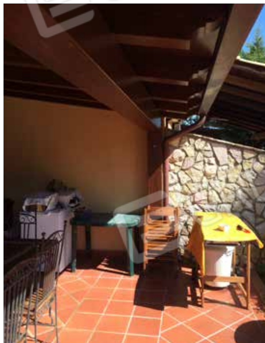
Foto 21. Portico sul prospetto retrostante.
