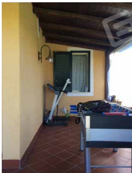
Foto 6. Portico sul prospetto principale.
