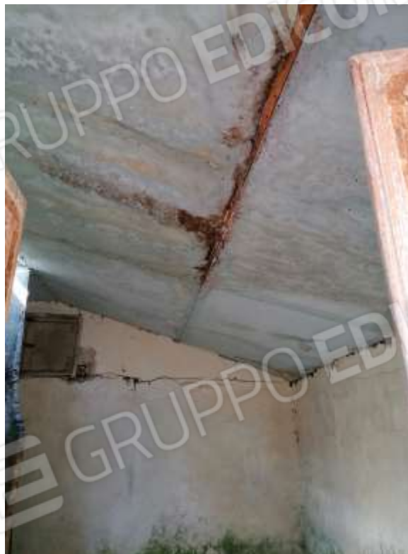
VISTA INTERNO CAMERA OVEST
