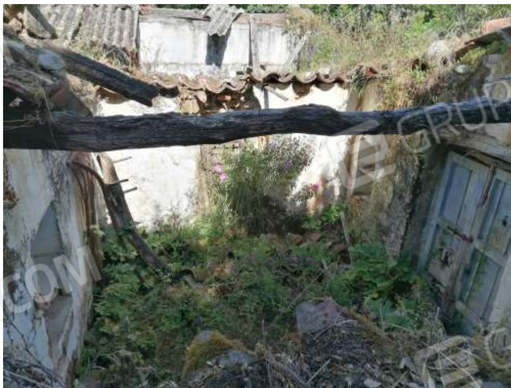
VISTA INTERNO CUCINA
