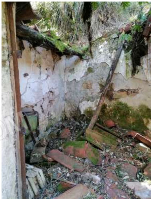
VISTA INTERNO W.C.
