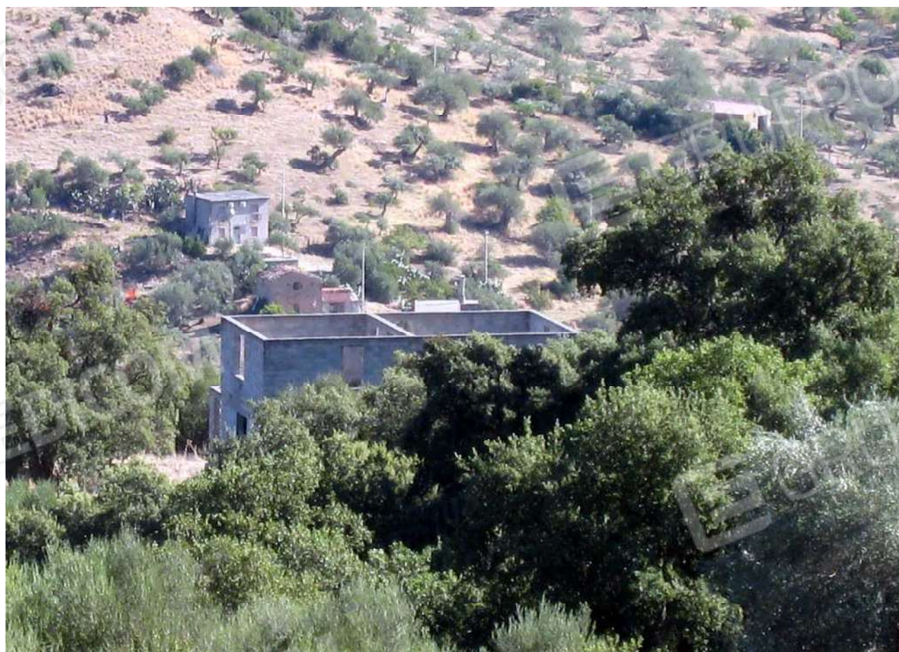
Foto n. 115. L'edificio è privo del tetto e la pioggia, nonché la neve, vi penetrano facilmente procurando gravi danni.
