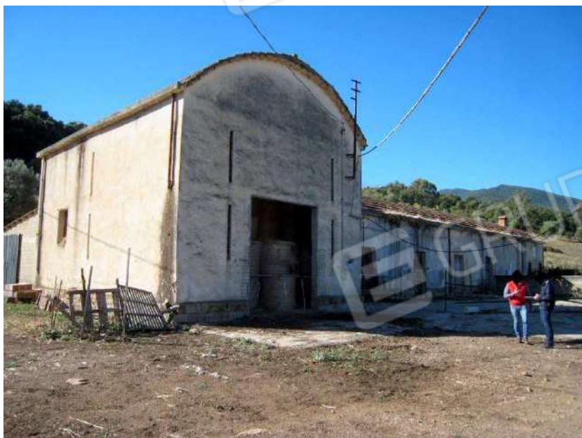
Foto n. 89. Prospetto Nord della p.lla 330.
