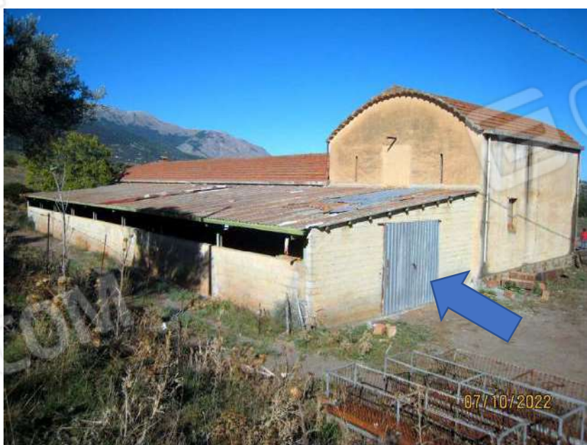
Foto n. 90. Il prospetto est e Sud. La freccia
