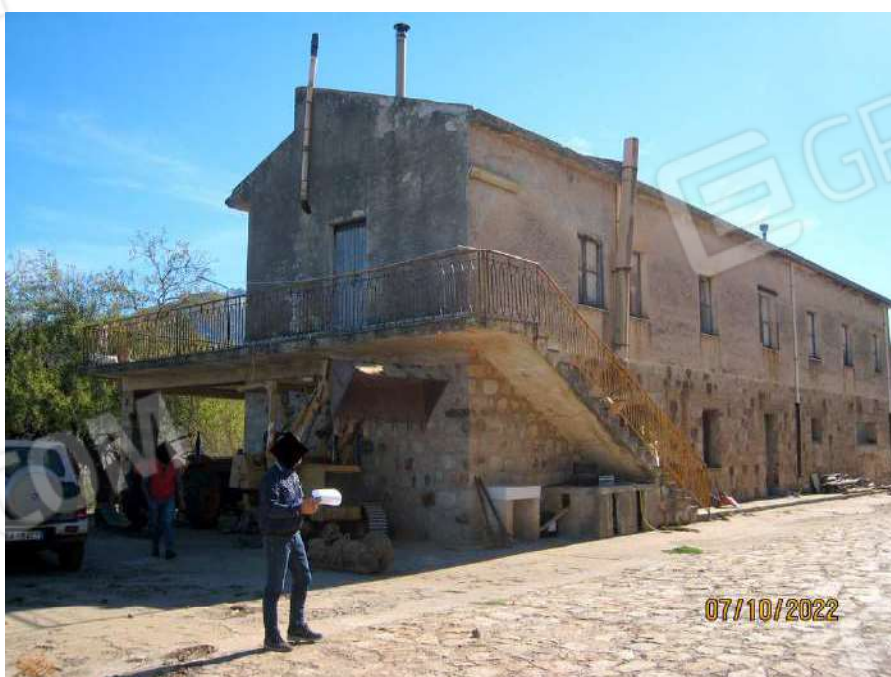
Foto n. 100-102. Il fabbricato distinto con la p.lla 335.
