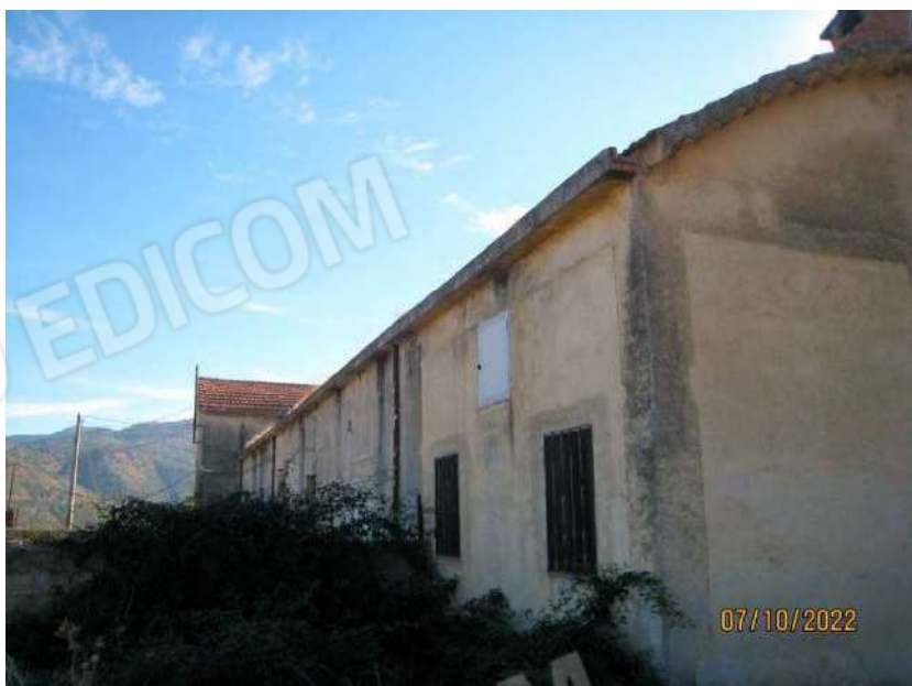
Foto n. 91. Il prospetto Nord visto dal lato
