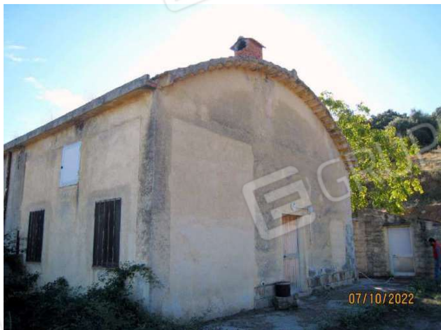
Foto n. 92. Il prospetto Ovest.
