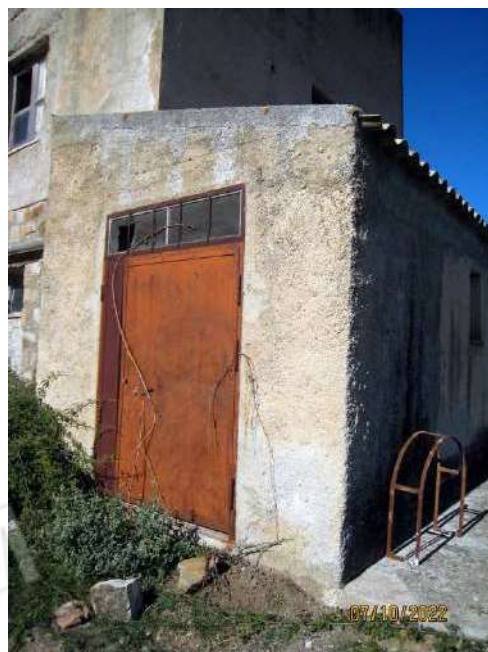
Foto n. 105-106. Il piccolo fabbricato addossato sul lato Sud-Est dell'edificio distinto con la p.lla 335.
