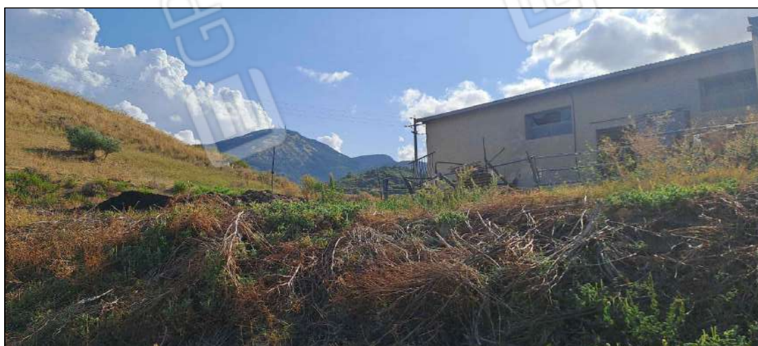
prospetto est- stalla, vista dalla strada
