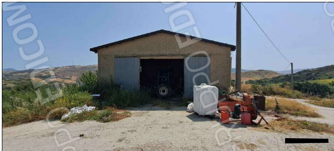
prospetto ovest- fienile
