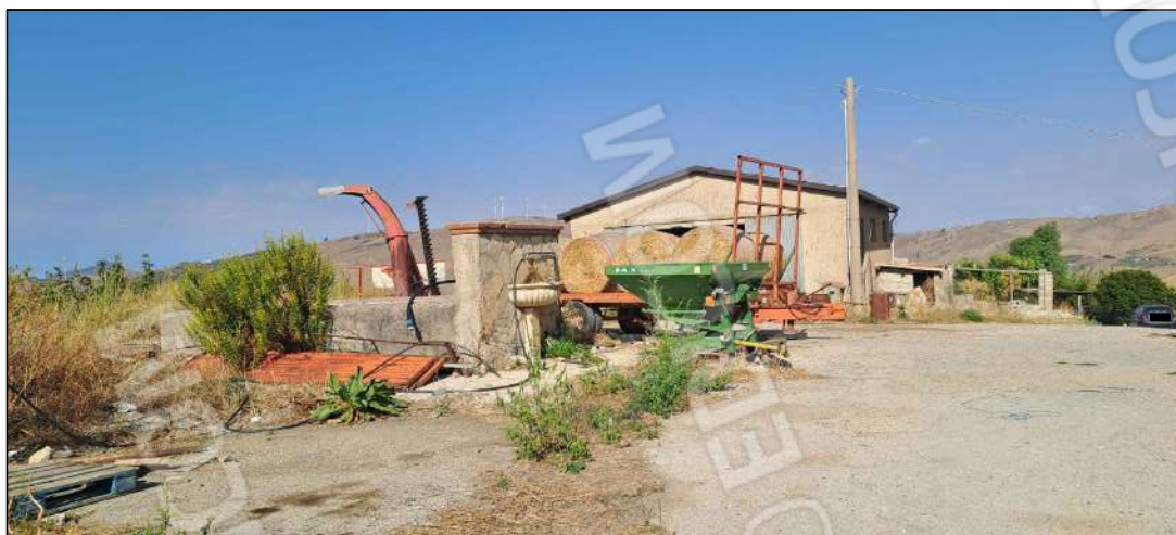
panoramica - abbeveratoio e prospetto ovest- fienile
