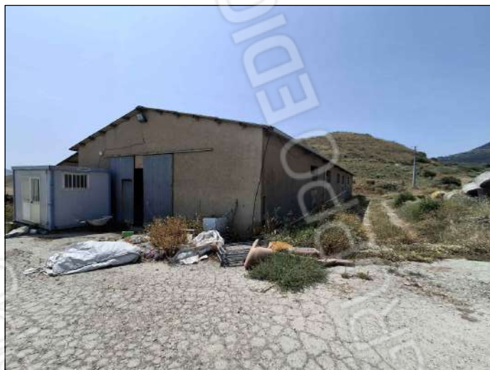
prospetto nord-ovest- stalla, vista dalla corte
