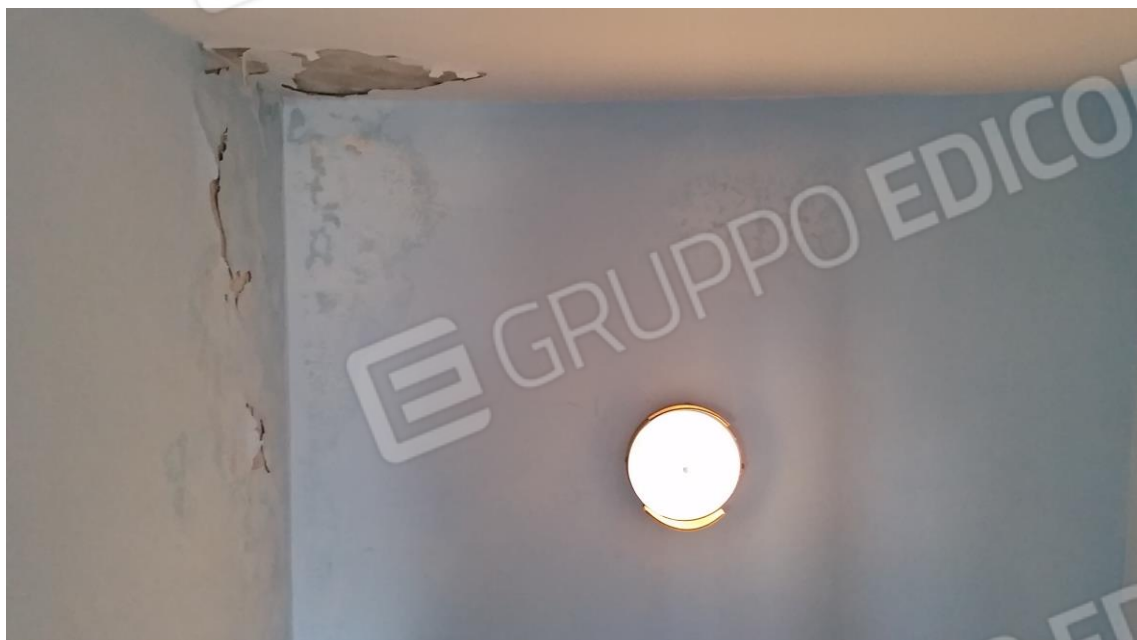
Figura 39: Particolare degli ammaloramenti presenti sull'intonaco delle pareti e dell'intradosso del solaio del vano scala
