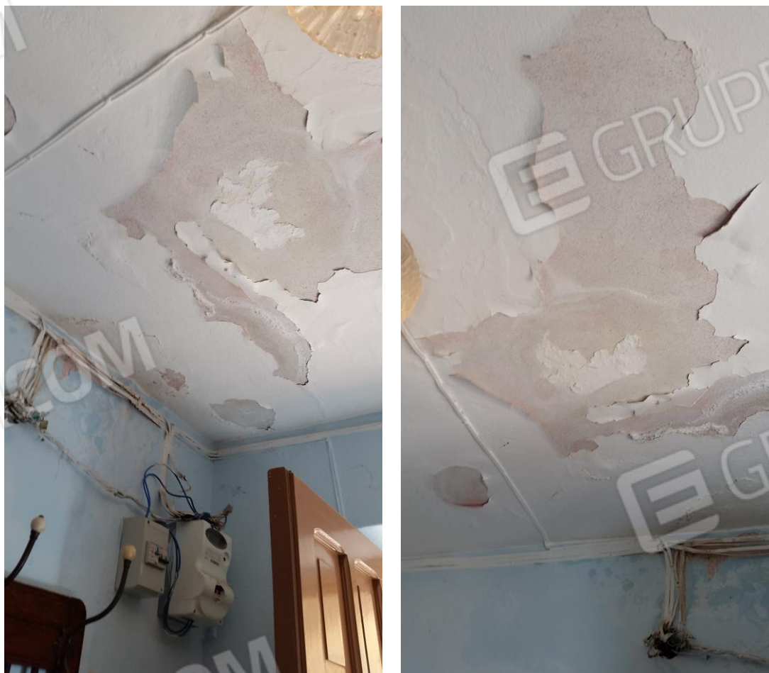
Figura 6-7: Ammaloramenti presenti in corrispondenza dell'intradosso del solaio nel vano d'ingresso dell'immobile de quo
